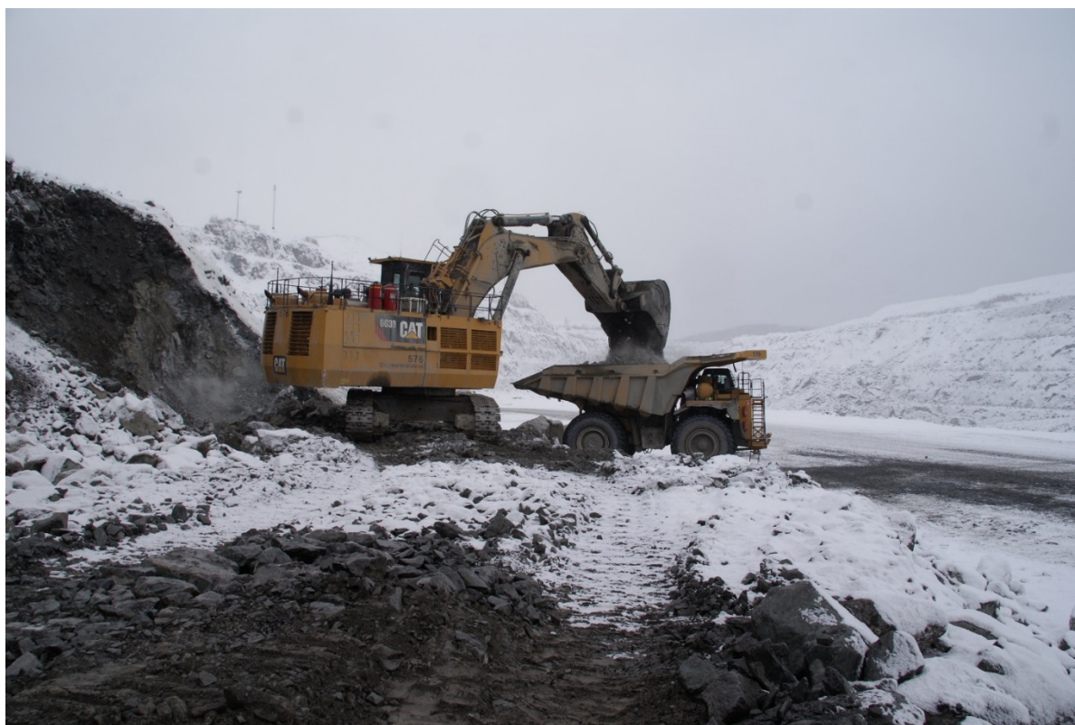
KUVA 3. Lastausta kuokkakaivinkoneella. Kaivinkone Caterpillar 6030 ja kiviauto Caterpillar 785D (Vitri 2016-02-25)
