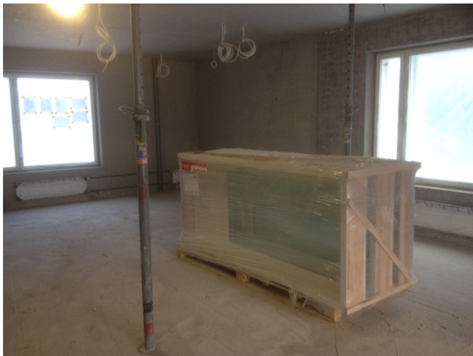
Kuva 9. Materiaalin varastointi ja suojaus työmaalla (Kuva: Otto Tevasaari)
