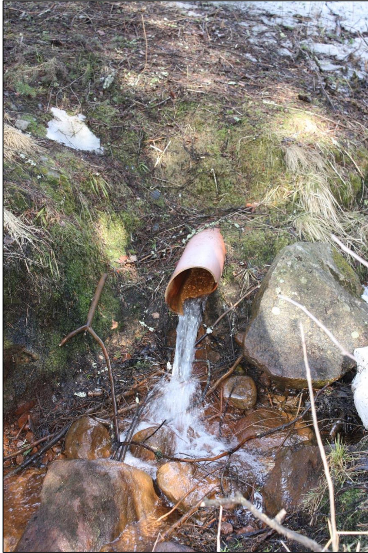
Kuvio 5. Hulevesiputki tien ali Rovaniemellä
