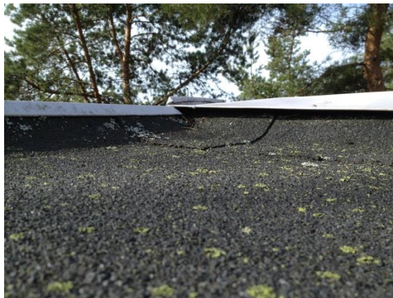
Kuva 4. Vesikaton kulman reunapelti.
