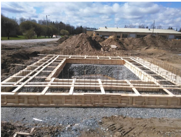
Kuva 9. Nauha-anturan raudoitustarkastusta
