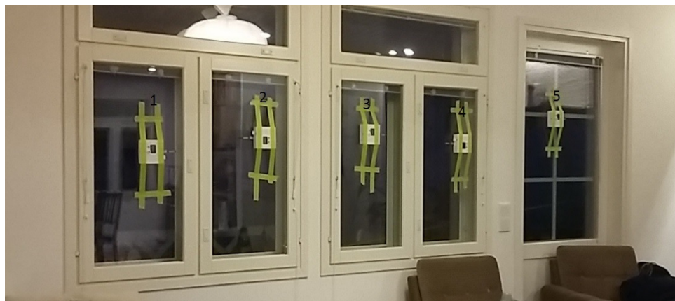
Kuva 11. Ikkunoiden mittaus 2. mittauskohteessa (Kuva: Mika Kivelä)
