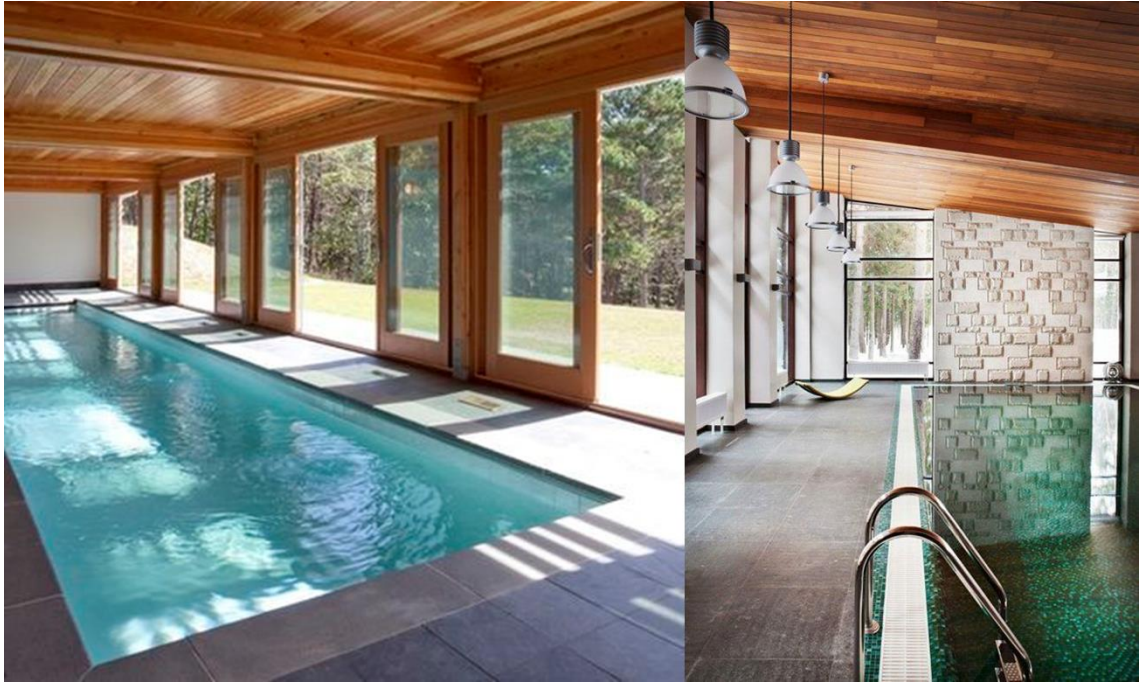
Kuva 20. Allastilan puuverhoiltu alakatto (Kuva: Pinterest 2016c).
