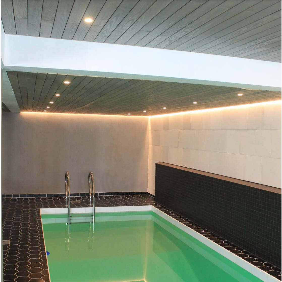
Kuva 41. Kourun tilalle rakennettu valmis seinäke (Kuva: Terhi Ilvonen 2016k).
