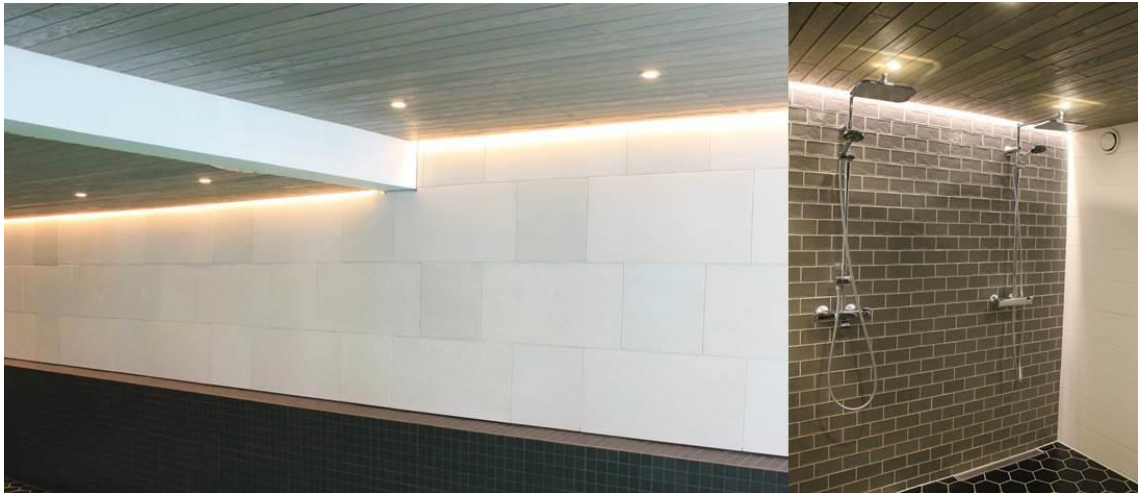
Kuva 39. Epäsuoravalaistus allasosastolla ja kylpyhuoneessa (Kuva: Terhi Ilvonen 2016i).
