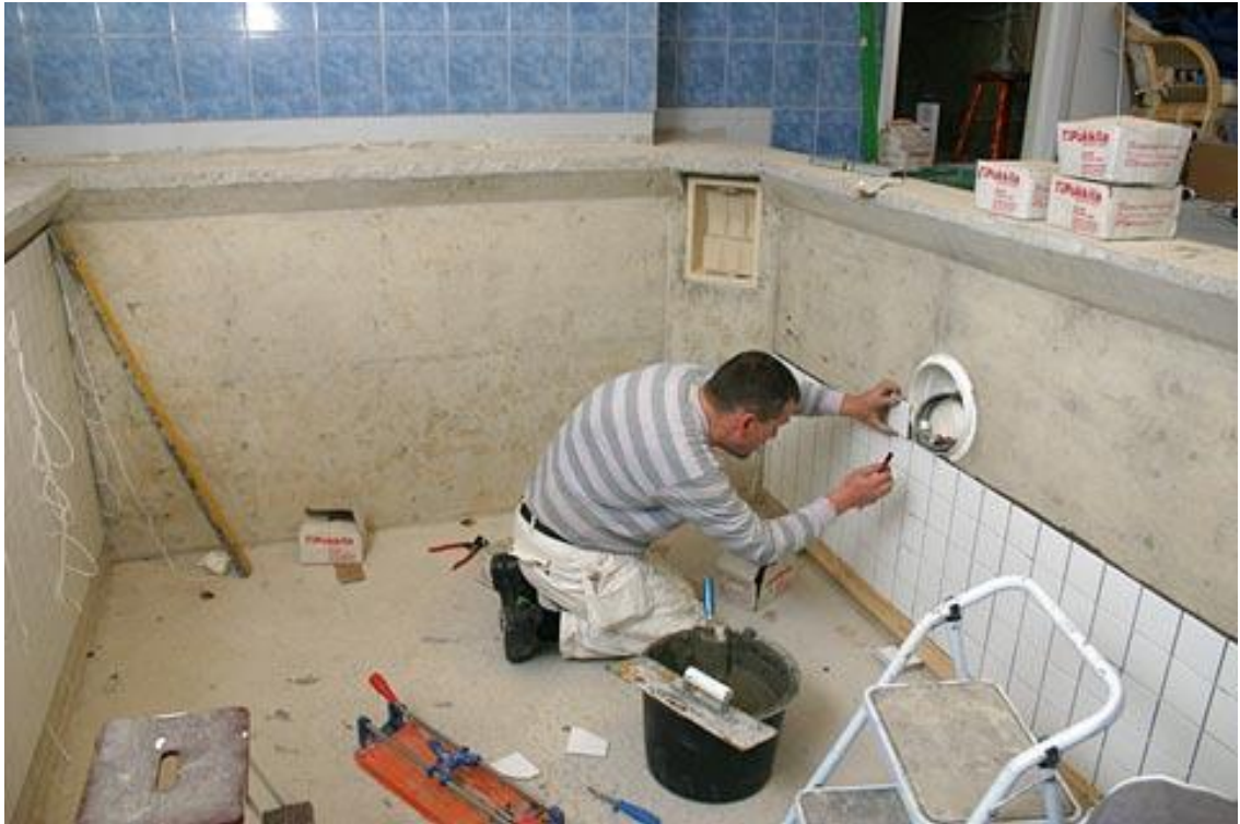
Kuva 22. Uima-altaan laatoitus on aloitettu oikeaoppisesti altaan seinäpinnoilta (Kuva: Rakentaja.fi)
