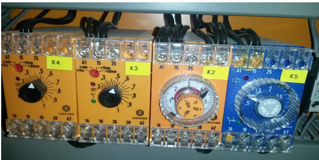
Kuva 1. Mekaaniset ajastinreleet (Roininen 2015)
