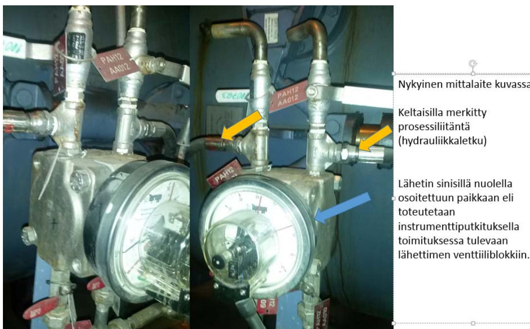
Kuva 12. Paine-erolähtetimen asennus (Roininen 2016).
