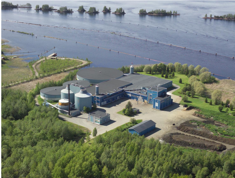
Kuva 7. Kuhasalon jätevedenpuhdistamo (Joensuun Vesi)
