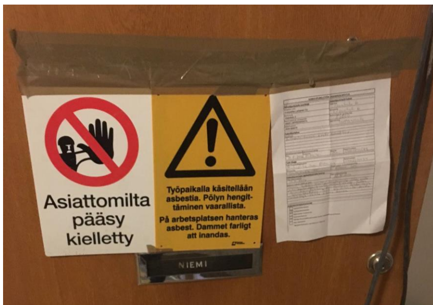
Kuva 13. Asunnon ovi asbestipurkutöiden alkaessa
