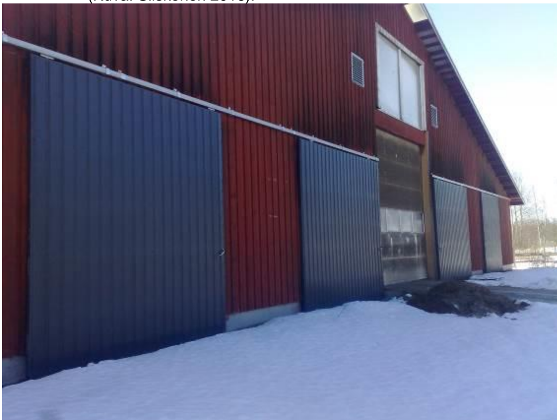
Kuva 13. Päädyn neljä liukuovea voivat hätätapauksessa toimia vaihtoehtoisina eläinten pelastusreitteinä (Kuva: Siiskonen 2016).
