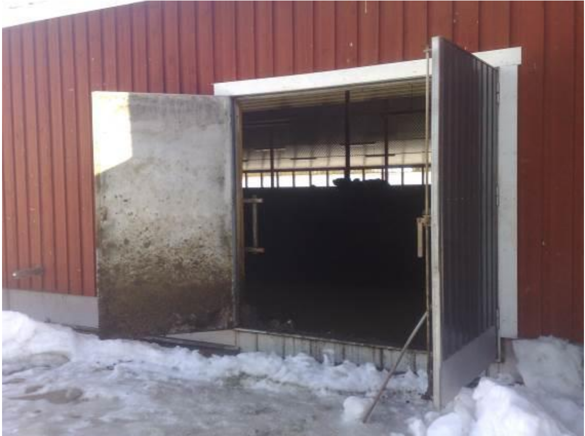
Kuva 10. Eläinten ensisijaisen pelastustien ulko-ovi jaloittelutarhaan (Kuva: Siiskonen 2016).
