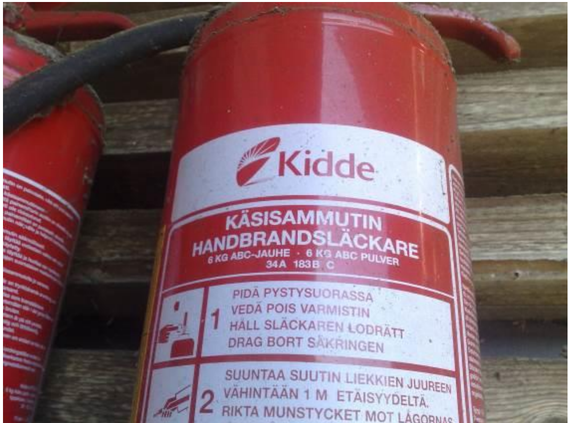
Kuva 6. Sammutinaineen merkintä käsisammuttimen kyljessä (Kuva: Siiskonen 2016).
