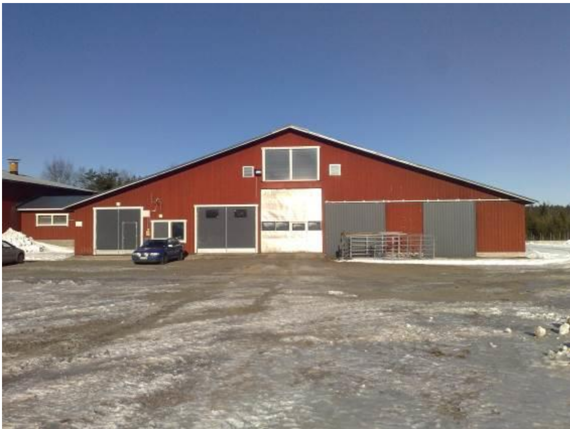
Kuva 12. Poikimakarsinan pariovet ja oikean puoleiset 2 liukuovea voivat hätätapauksessa toimia vaihtoehtoisina eläinten pelastusreitteinä (Kuva: Siiskonen 2016).
