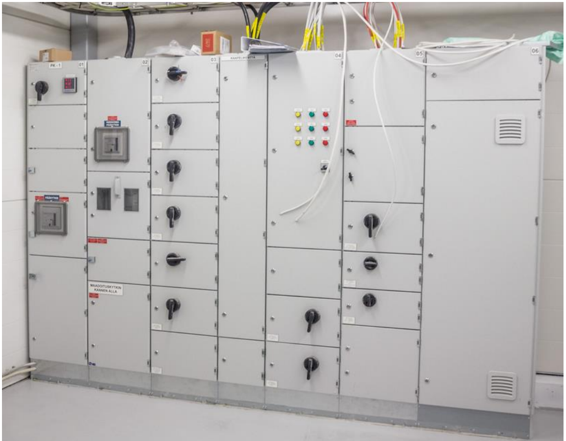
Kuva 4. Sähköpääkeskus (Pahus 2015)
