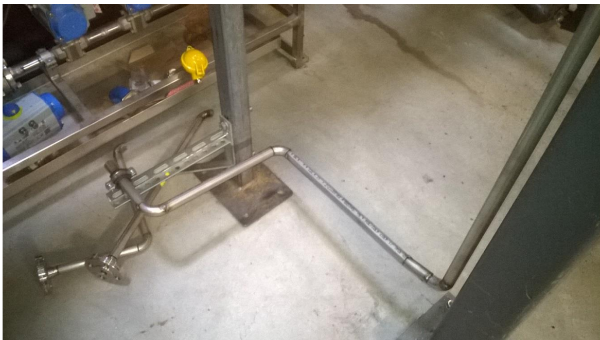
KUVA 3. Takaisin kierrätyslinja venttiilikoneikolta
