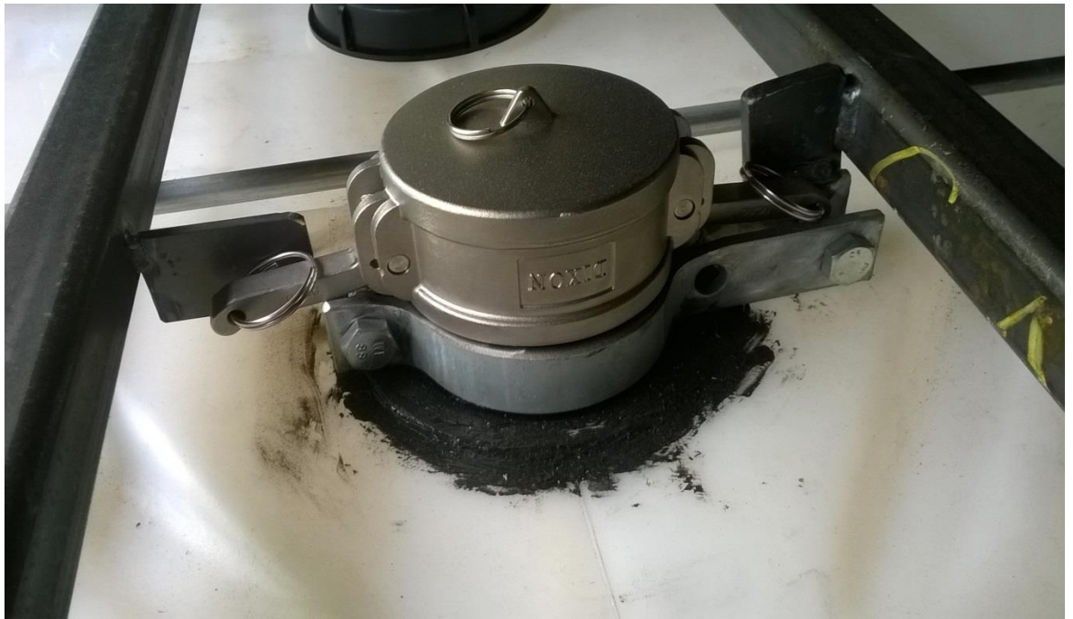
KUVA 5. Camlock täyttöliitin
