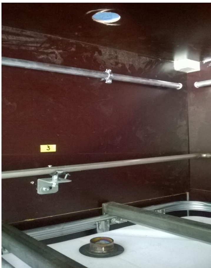
KUVA 10. Huohotinputken paikka
