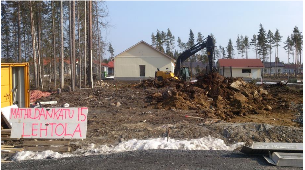
Kuva 1. Rakennuslupa myönnetty ja työt aloitettu.
