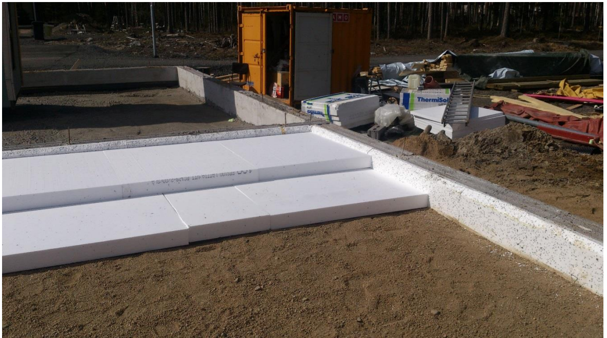
Kuva 2. Talkoolaiselle sopivaa kevyttä maanvaraisen laatan styroksin asennustyötä.
