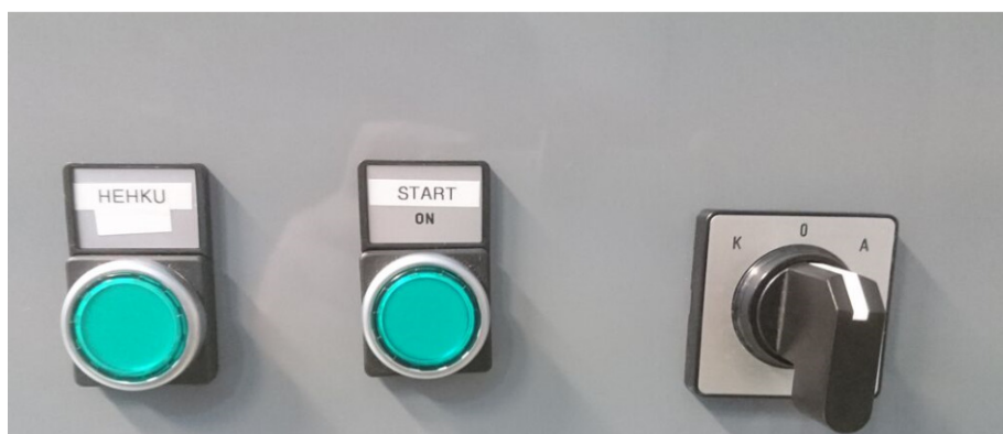
Kuva 9 Paikallisohjauksen hehku- ja startti-painikkeet, sekä nokkavalintakytkin
