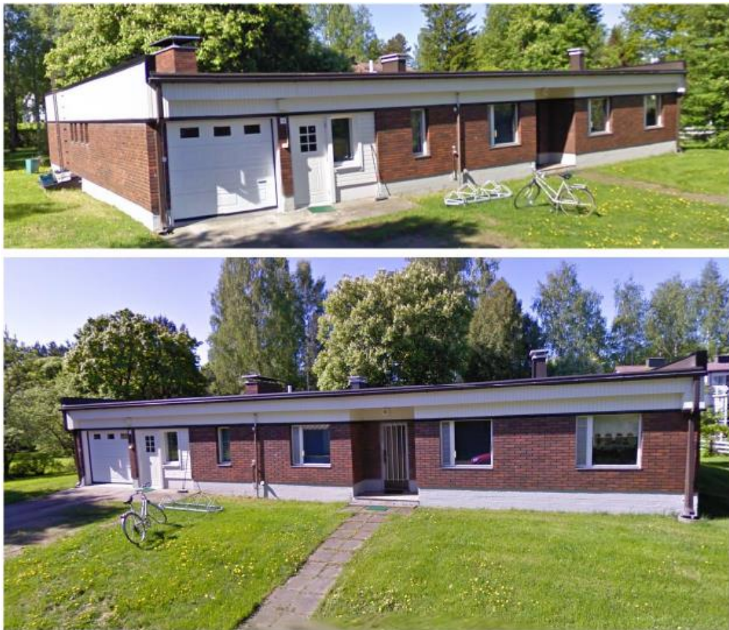
Kuva 1. Rakennuksen julkisivu. (Kuva: Google Street View)
