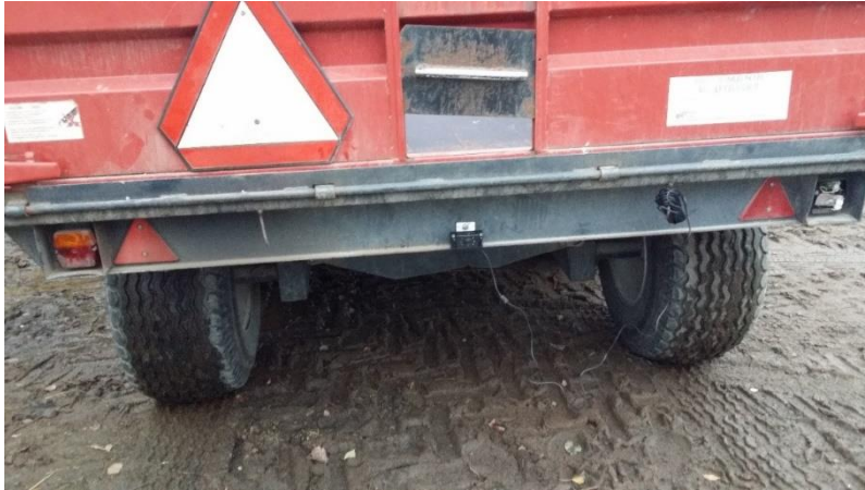
Kuvio 4. Peruutuskameran asennus vaiheessa. Kuva: Ahola Noora
