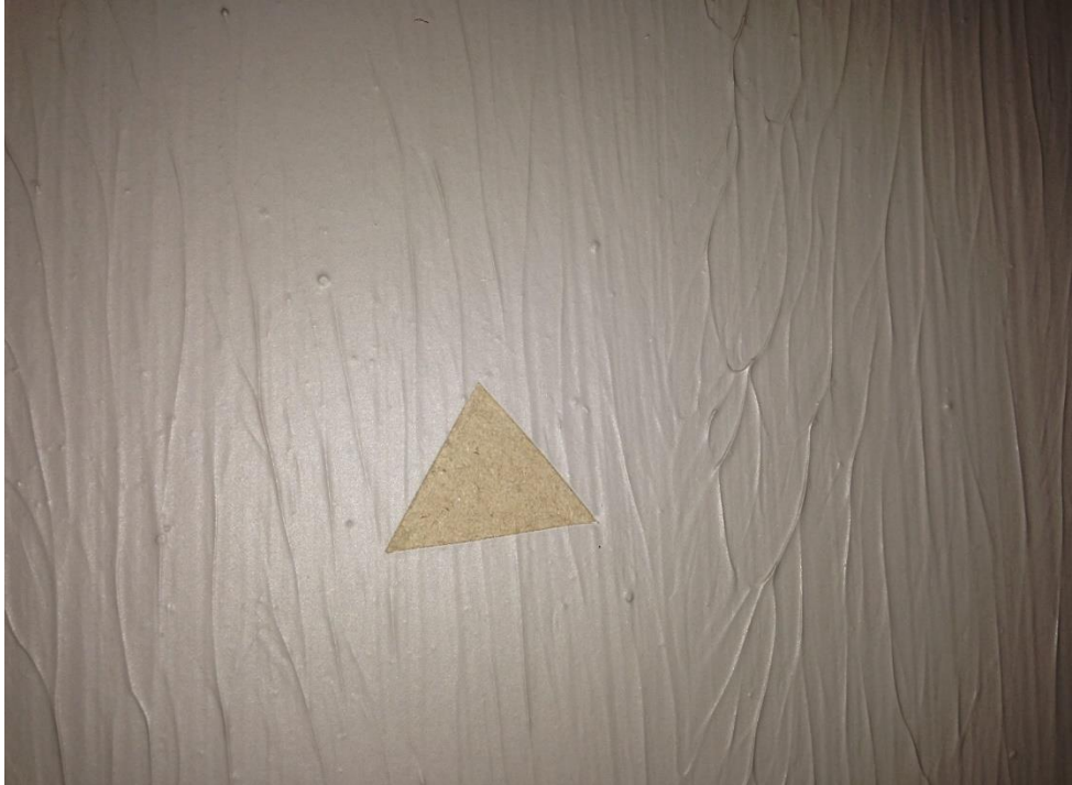
Kuva 3. Seinästä otettu koepala vesieristeen paksuuden mittaamiseksi.
