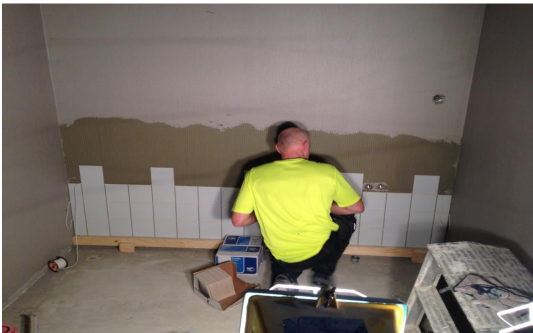
Kuva 4. Korkorima asennettu korkoonsa ja laatoitus aloitettu.
