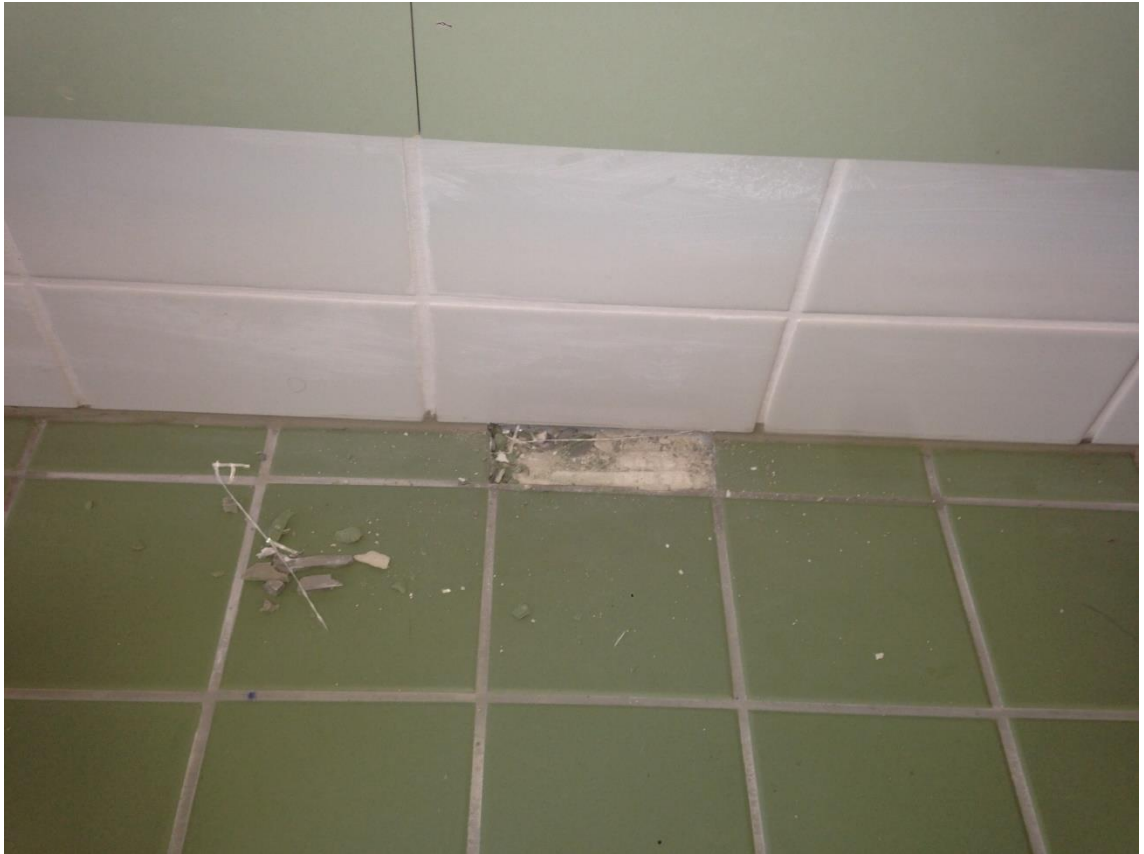
Kuva 5. Hajonnut laatta poistetaan ja korvataan ehjällä.
