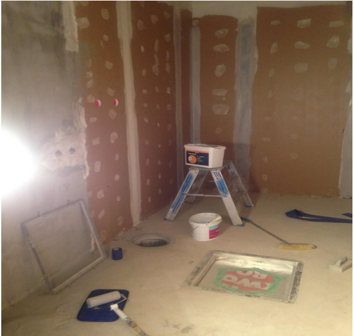
Kuva 2. Seinien vesieristys ja saumojen nauhoitus meneillään.
