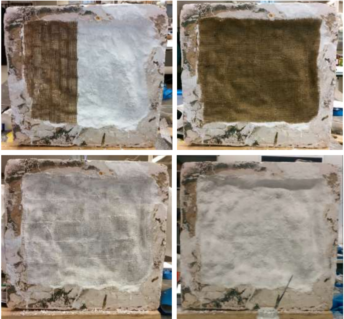
Kuva 32. Jalustan pohjan vahvistukseen sisältyi monta työvaihetta.
