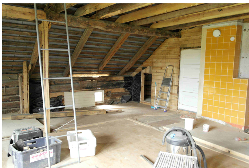
KUVIO 16. Yläkerta purkutöiden jälkeen, oikealta laattaseinän edestä purettu wc
