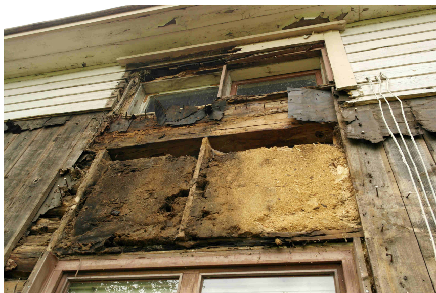
KUVIO 15. Jäännös eteläseinän isoista ikkunoista; painuneet purut ja eristämätön kohta
