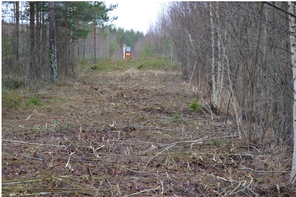
Kuva 11. Tehojätkällä tehty linjaraivaus.
