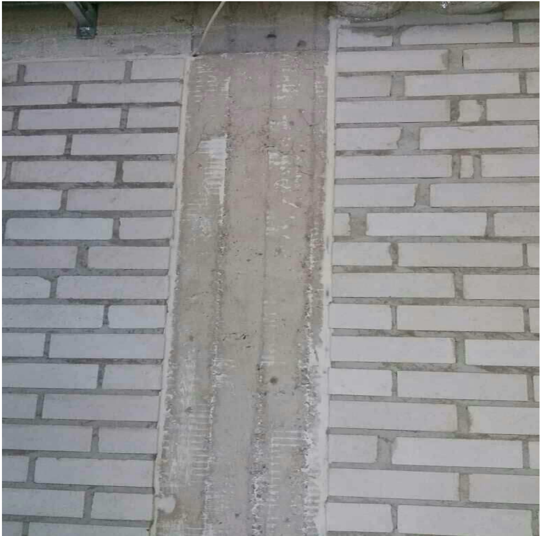
Kuva 1 Väliseinän ja pilarin liitos tiivistettynä paloakryylimassalla
