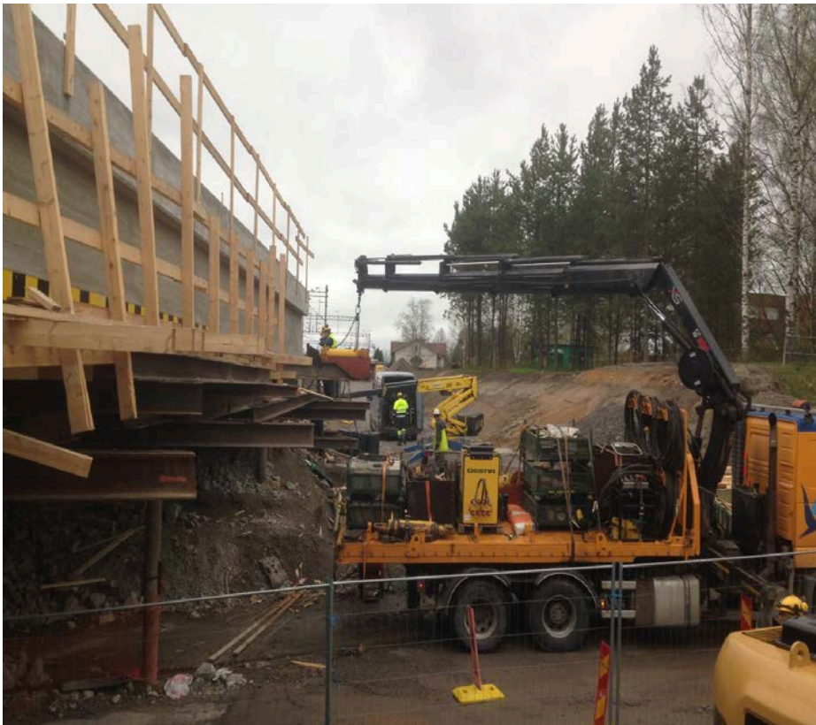
KUVA 5. Työntötunkkien asennus
