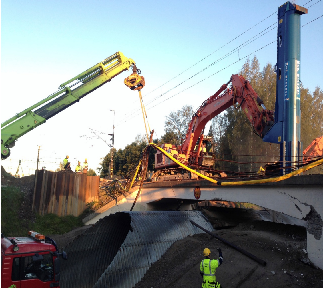
KUVA 3. Kannuksen vanhan alikulkusillan purku
