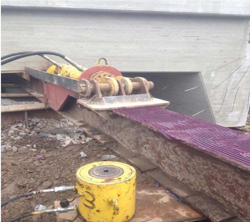
KUVA 8. Hydraulinen veto- ja nostotunkki
