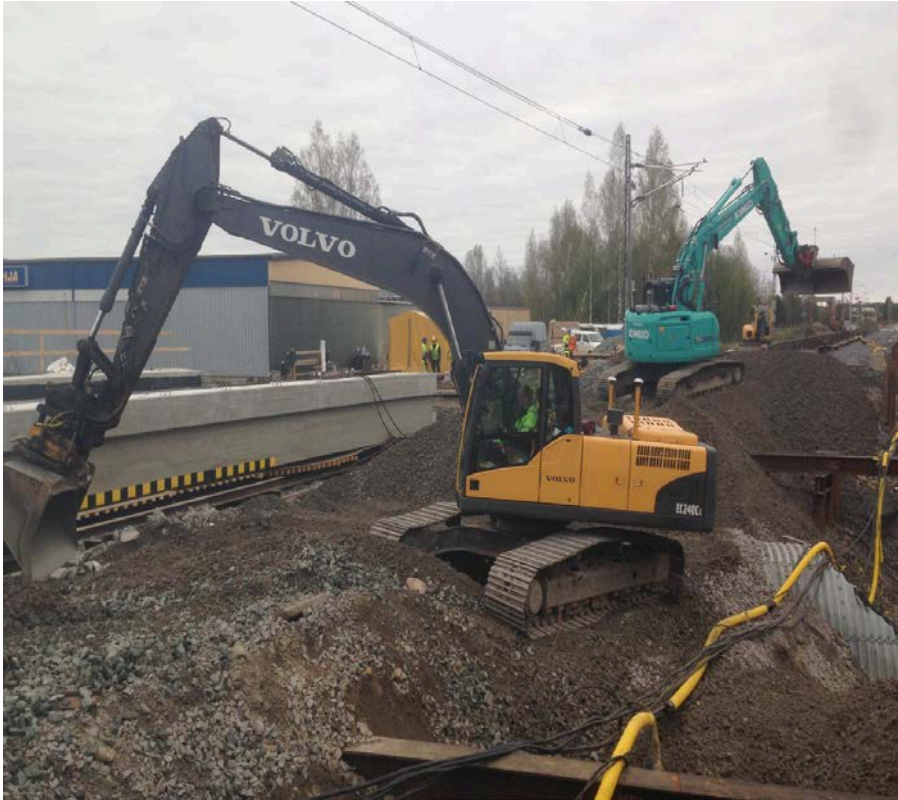
KUVA 7. Ratapenkan poisto kahdella tela-alustaisella kaivinkoneella
