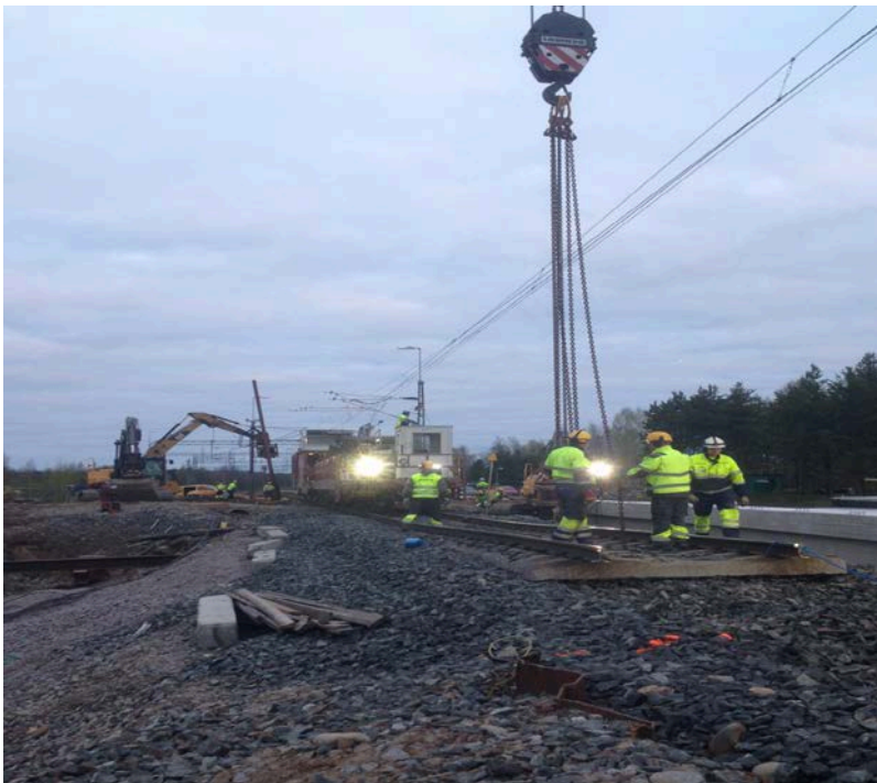
KUVA 6. Ratatelementtien poisto autonosturilla (NAH)
