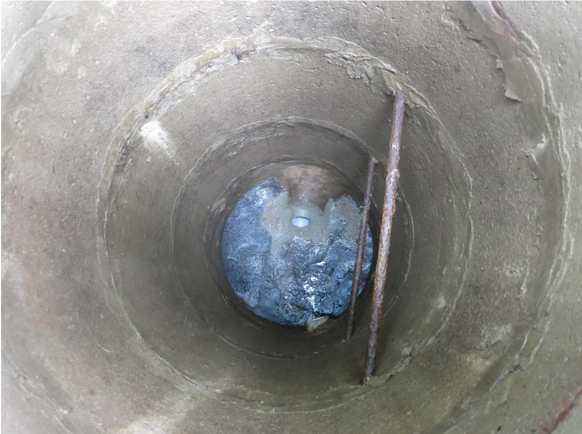
KUVA 13. Valettuliitos tarkastuskaivossa
