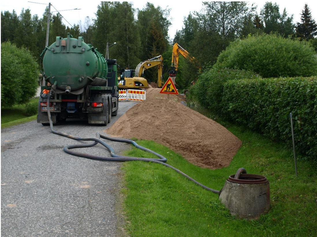
KUVA 9. Viemäriin kuivana pito imuautolla
