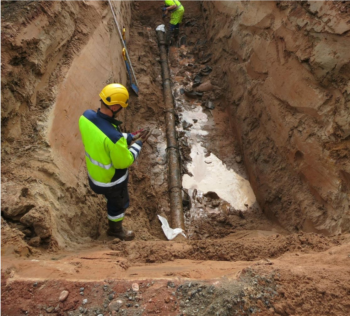
KUVA 14. Viemärilinja auki kaivettuna, betoniviemäri purettu
