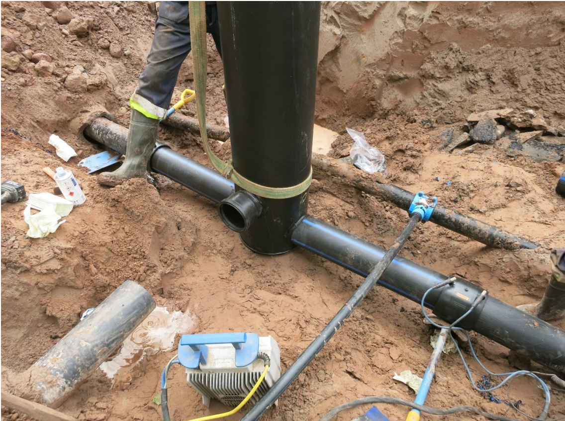
KUVA 10. Viemäriputken hitsaus
