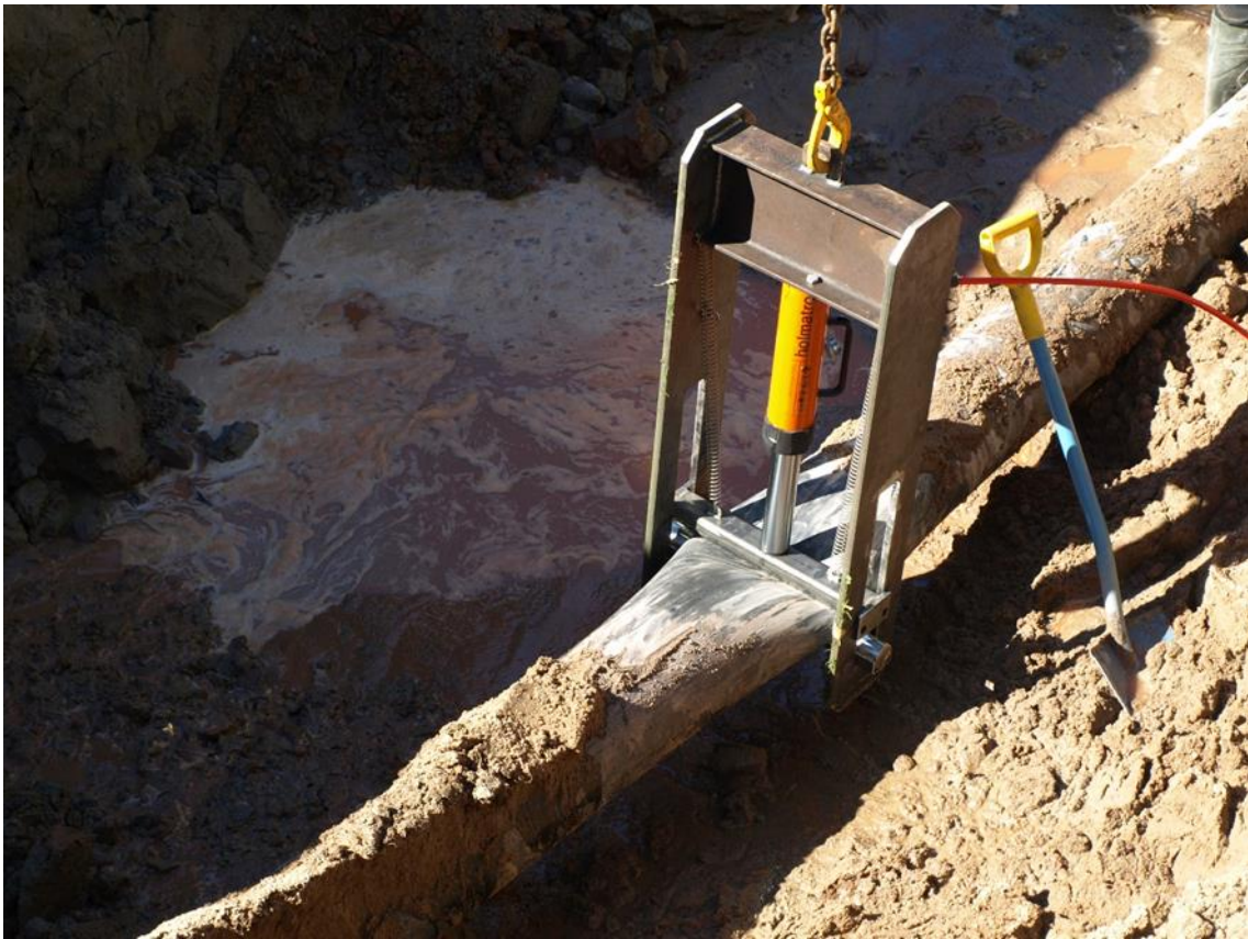
KUVA 11. PE-250 paineviemäarin litistys, putkenlitistäjällä
