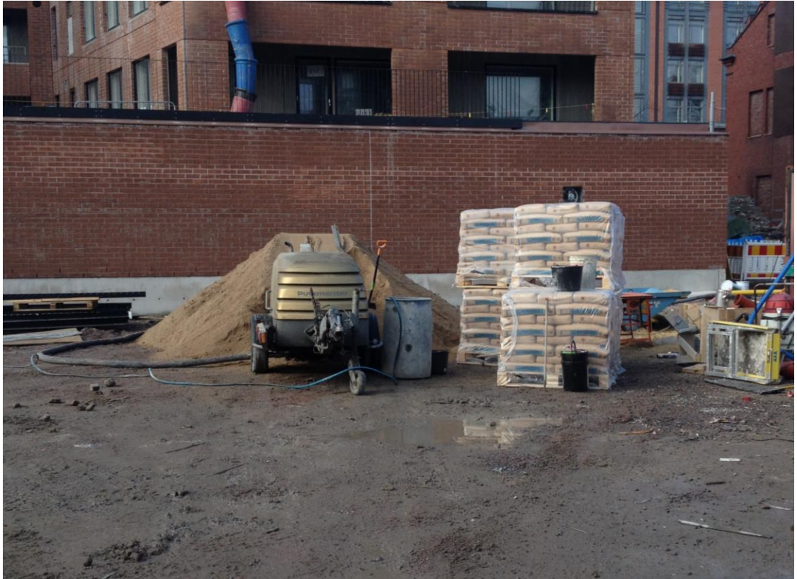
Kuva 3. Estrich-pumppu, materiaalit ja tarvikkeet työmaa-alueella.
