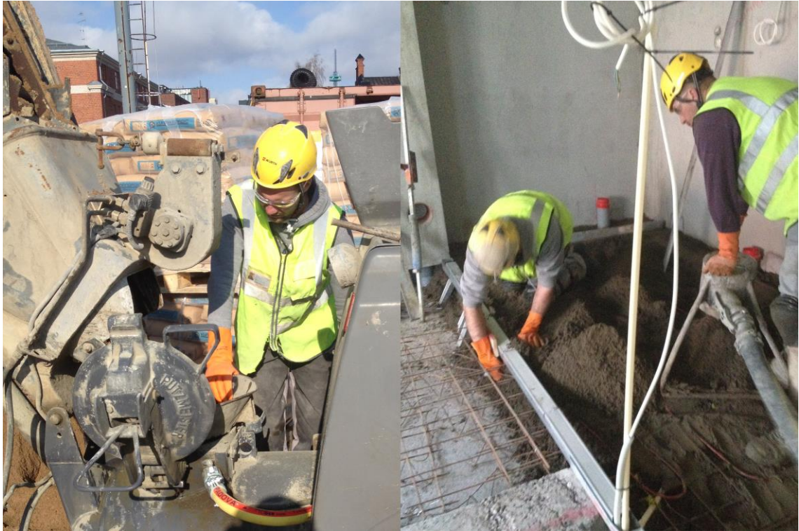
Kuva 4. Massan sekoitusta ulkona ja levittämistä betonointikohteessa.
