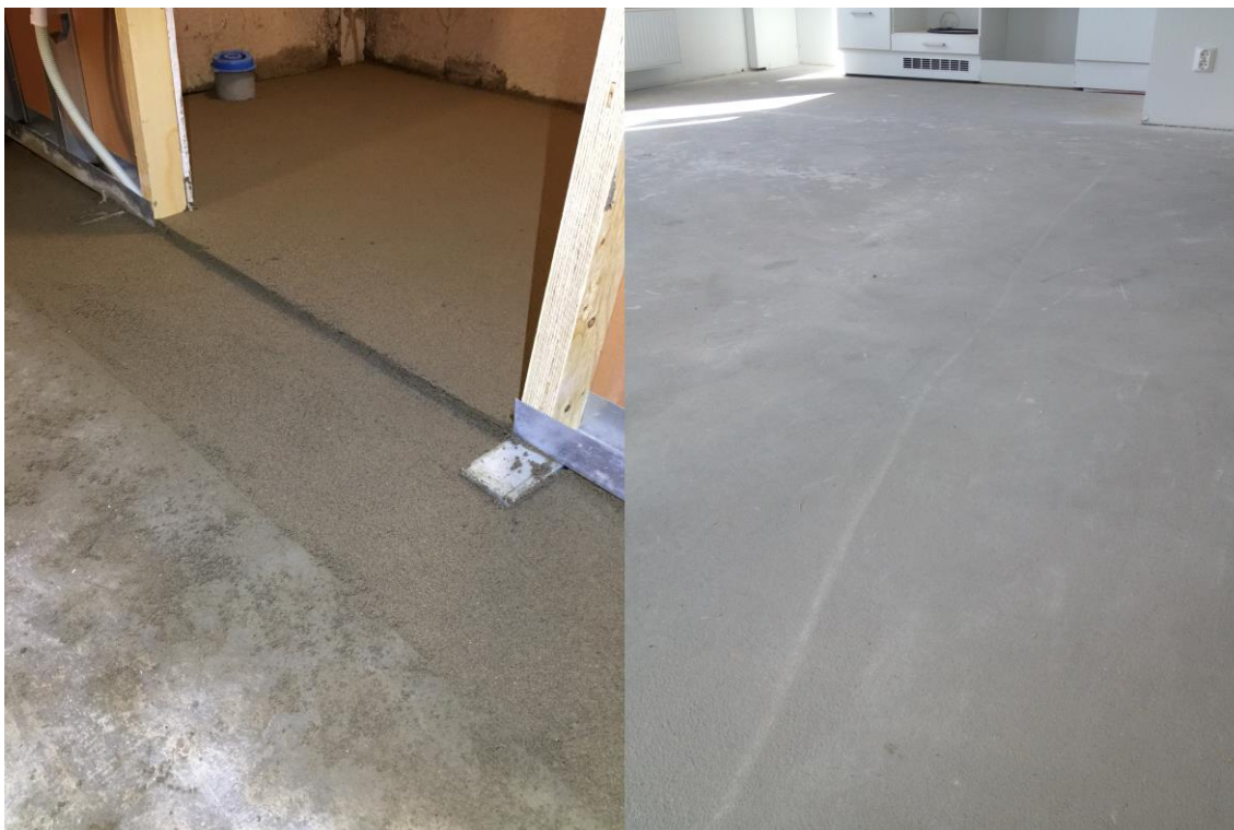
Kuva 6. Valmis valettu lattia ja kuivut päällystettävä lattia [16].
