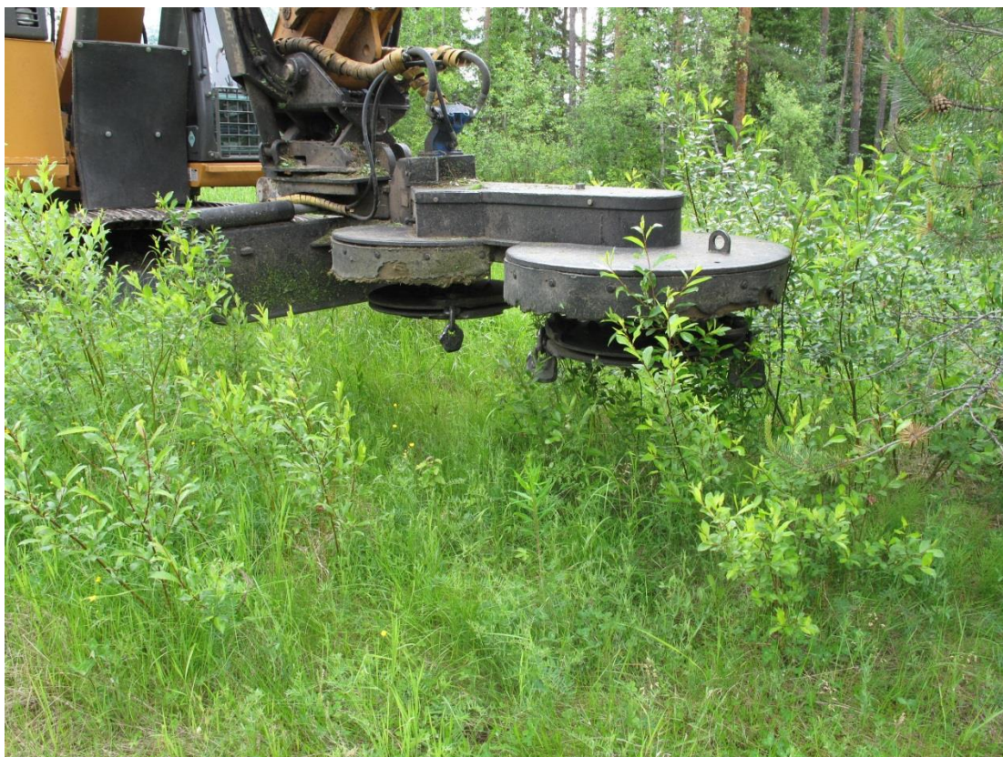
KUVA 6. Kaivinkoneen hydraulinen raivauskone (LSV 2016.)
