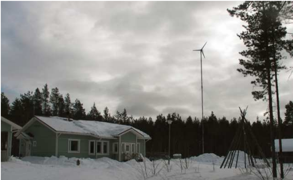
FIGURE 33 Tuule E200 with a 27 meter mast installed in Northern Ostrobothnia. (Finnwind Oy, links Referenssit -> Tuule E200 tuulivoimala, Pohjois-Pohjanmaa.)
