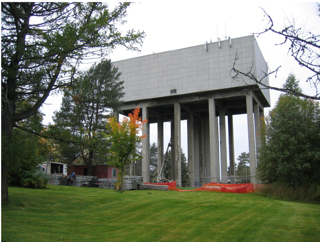
Kuva 4. Niinivaaran uudempi vuonna 1957 valmistunut vesitorni saneerauksessa vuonna 2008. (Joensuun Veden valokuva-arkisto 2008)
