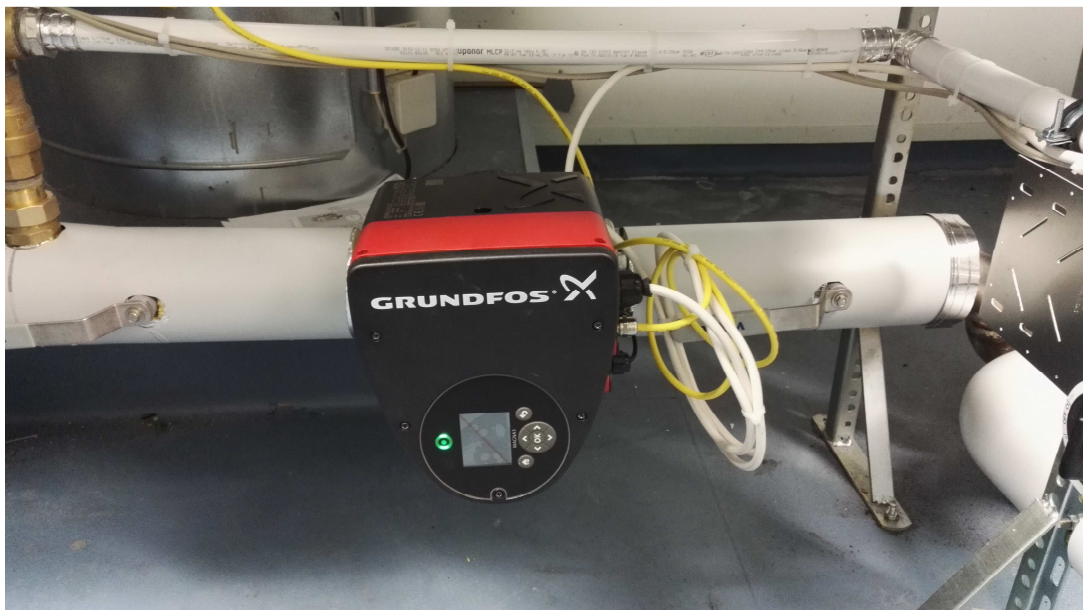
KUVA 6. Grundfos Magna lämmönjohtopumppu, jossa myös energiamäärän mittausta
