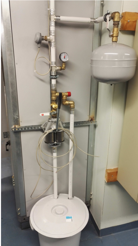
KUVA 8. Kompressorin lämmöntalteenottojärjestelmän täyttöryhmä ja varolaitteisto. Järjestelmän jäähdytysnesteenä 25 % etyleeniglykoli- /vesiseos
