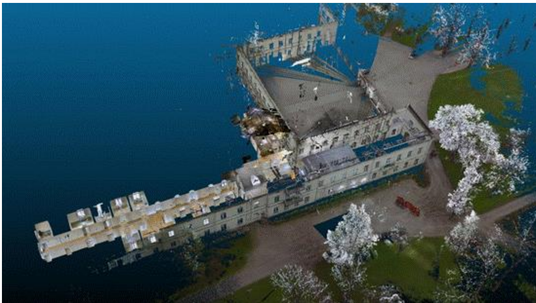
Kuva 19. Matterport-sisätilamittalaitteella tuotettu sisätilamalli yhdistettynä rakennuksen ulkopinnan laserkeilaimella mitattuun aineistoon. Kuva: JP Virtanen.
