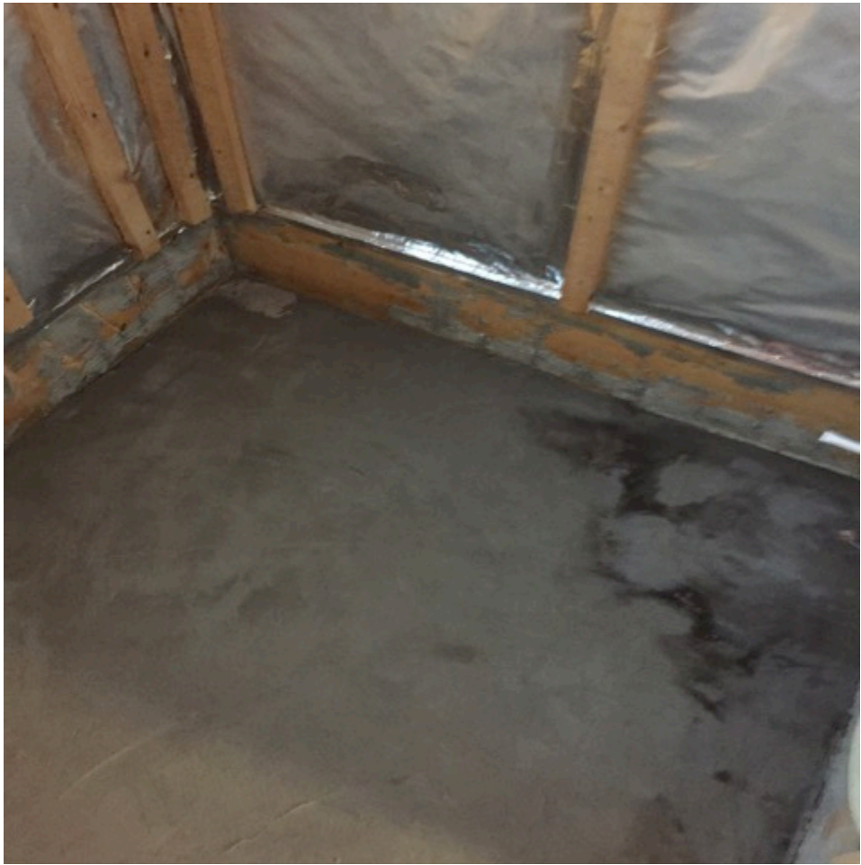
Kuva 14. Puretun saunatilan lattialaattaa ja vanerinosto. (Kuva: Valteri Salonen 2016)
