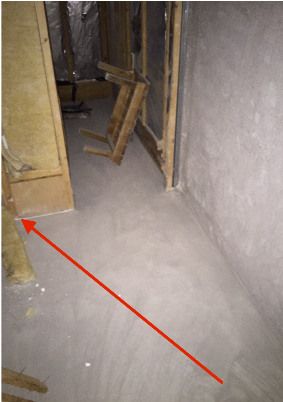
Kuva 20. Yleiskuva purettavasta kylpyhuonetilasta, jossa näkyvät myös puiset alajohjauspuut. (Kuva: Valtteri Salonen 2016)
