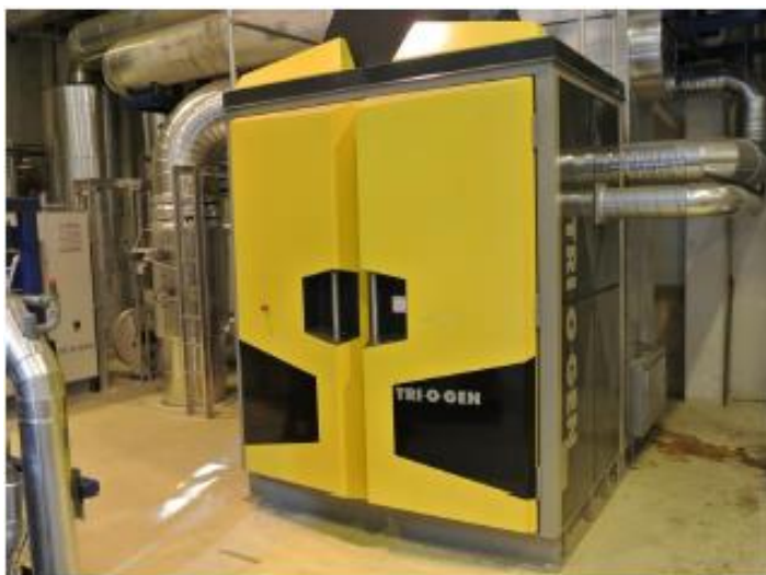
KUVA 6. Viikinmäen ORC-laitteisto (Korhonen 2014)
