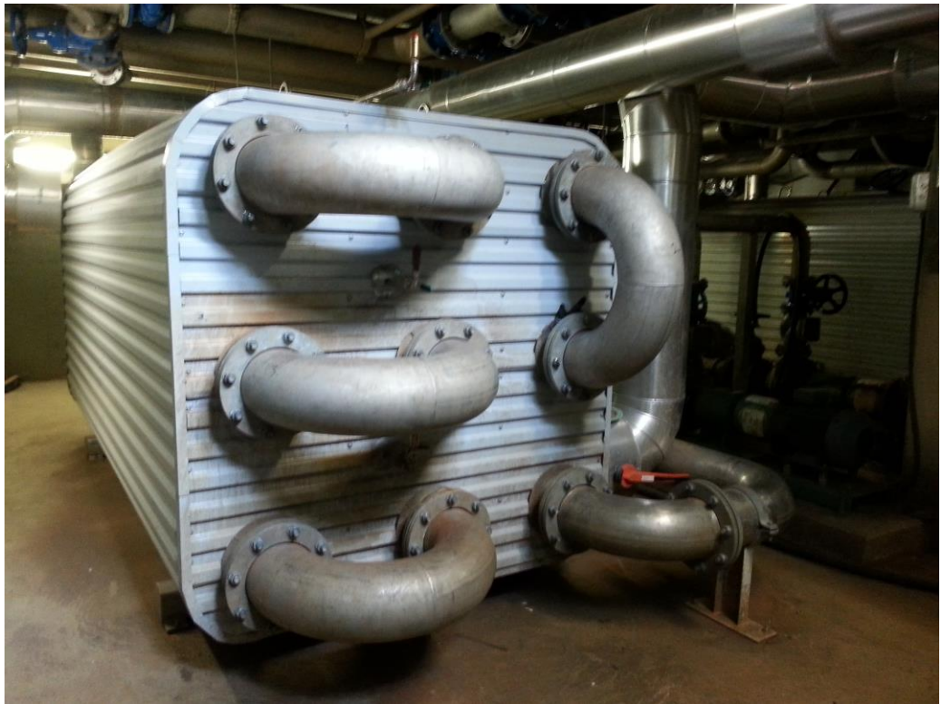
KUVA 3. Sekalietteen lämmönvaihdin.
