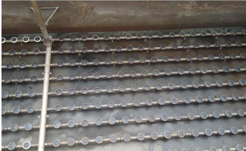
KUVA 5. Ilmastimien vuosihuolto.
