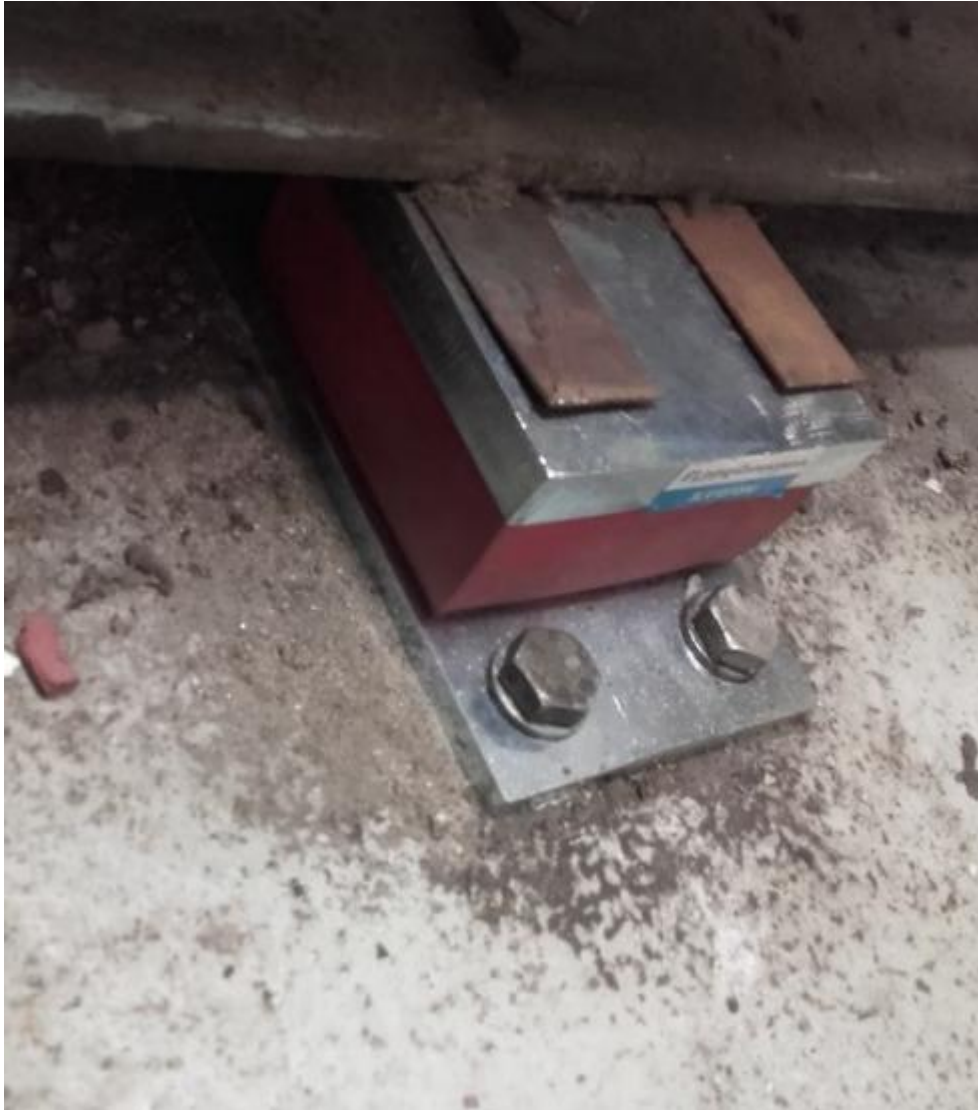
KUVA 15. Ilmateollisuuden puhaltimen alla oleva tärinävaimennin
