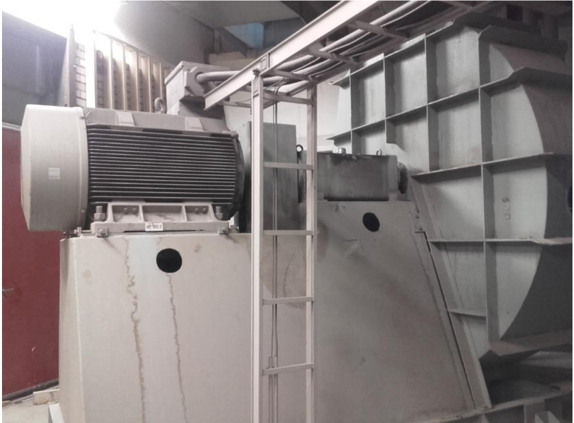
KUVA 18. Ilmateollisuuden puhallin ja tämän moottori
