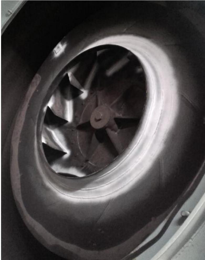
KUVA 19. Ilmateollisuuden puhaltimen siipipyörä
