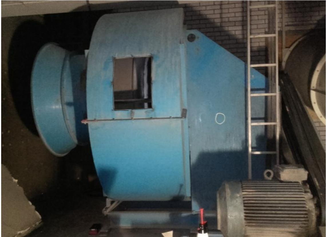
KUVA 17. Kojan hihnavetoinen jäähdytyspuhallin
