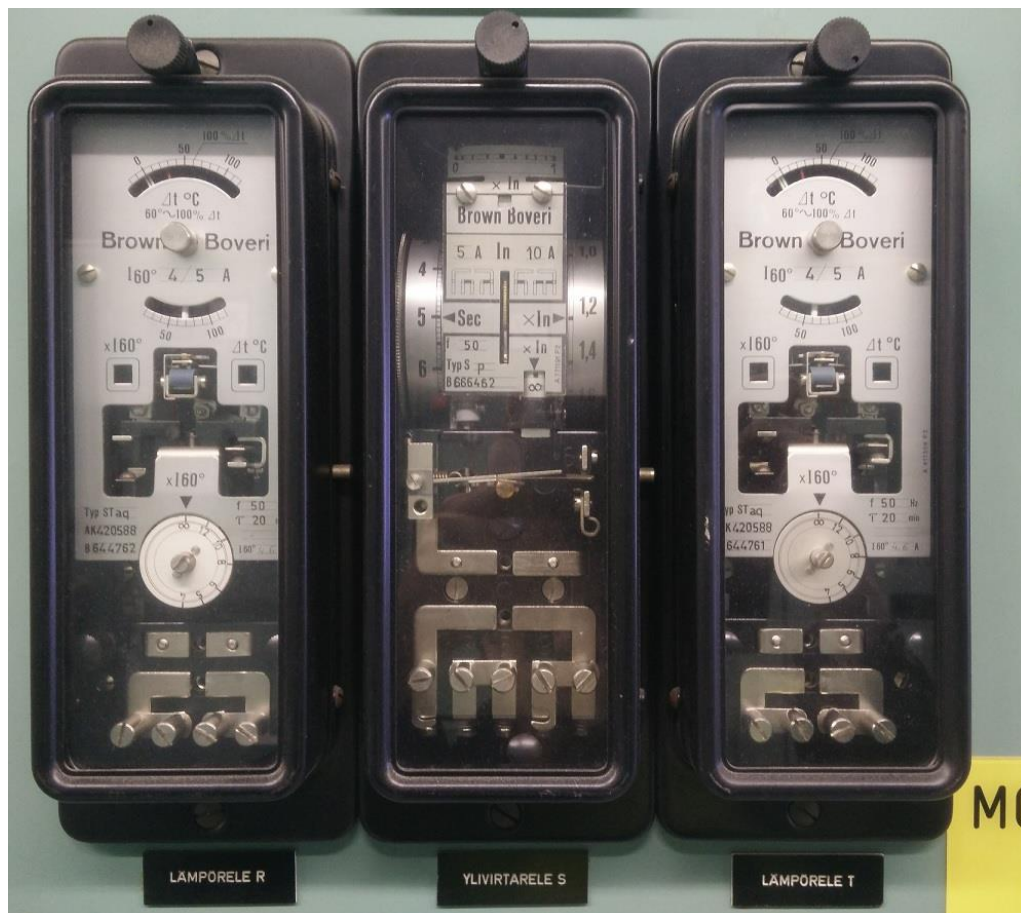
Kuva 3. Brown Boverin mekaanisia suojareleitä.
