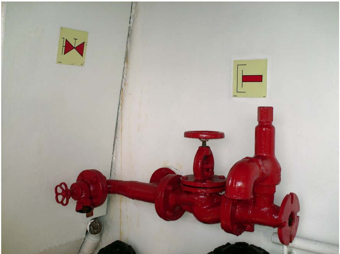
Kuva 16. Paloposti varustettuna kansainvälisellä laituriliitin-paikalla sekä molempien symbolit.
