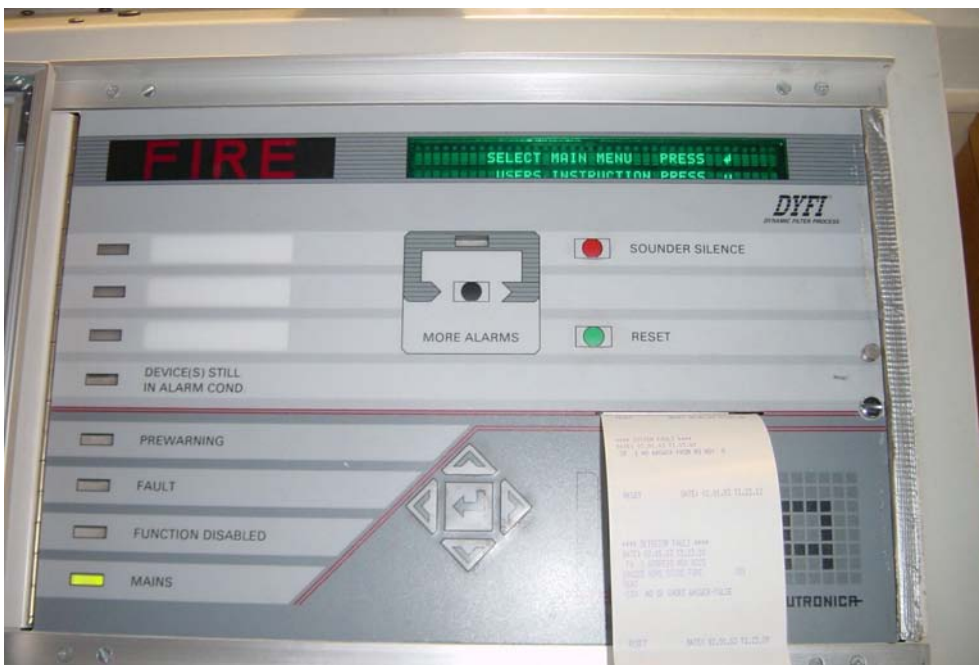
Kuva 21. Palohälytyskeskus varustettuna printterillä.
