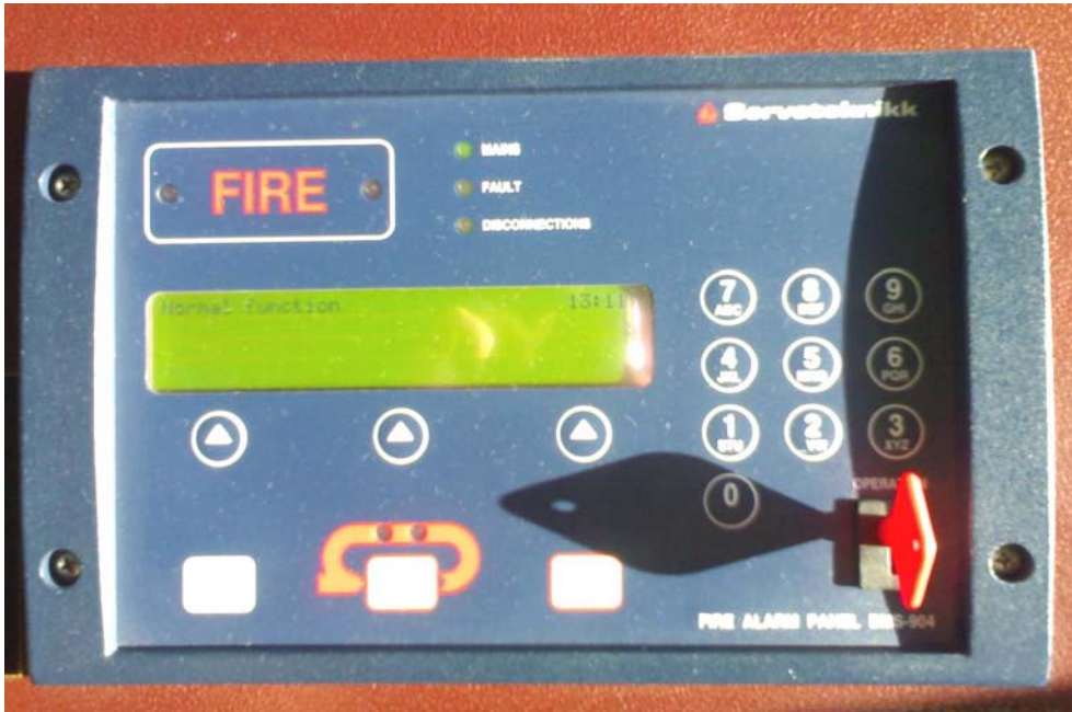
Kuva 20. Palohälytyskeskus varustettuna LED-näytöllä. (Kuva: Olli Vesanto)
