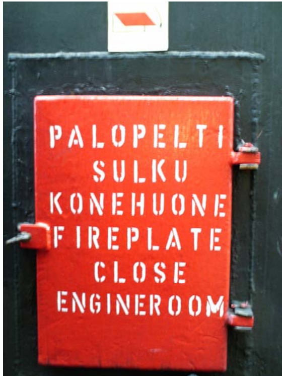
Kuva 7. Konehuoneen palopeltien sulkupaikka.
