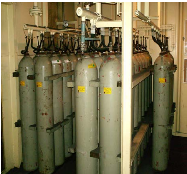
Kuva 13. Konehuoneen CO 2 -pullopatteristo sekä niiden laukaisukaappi.
