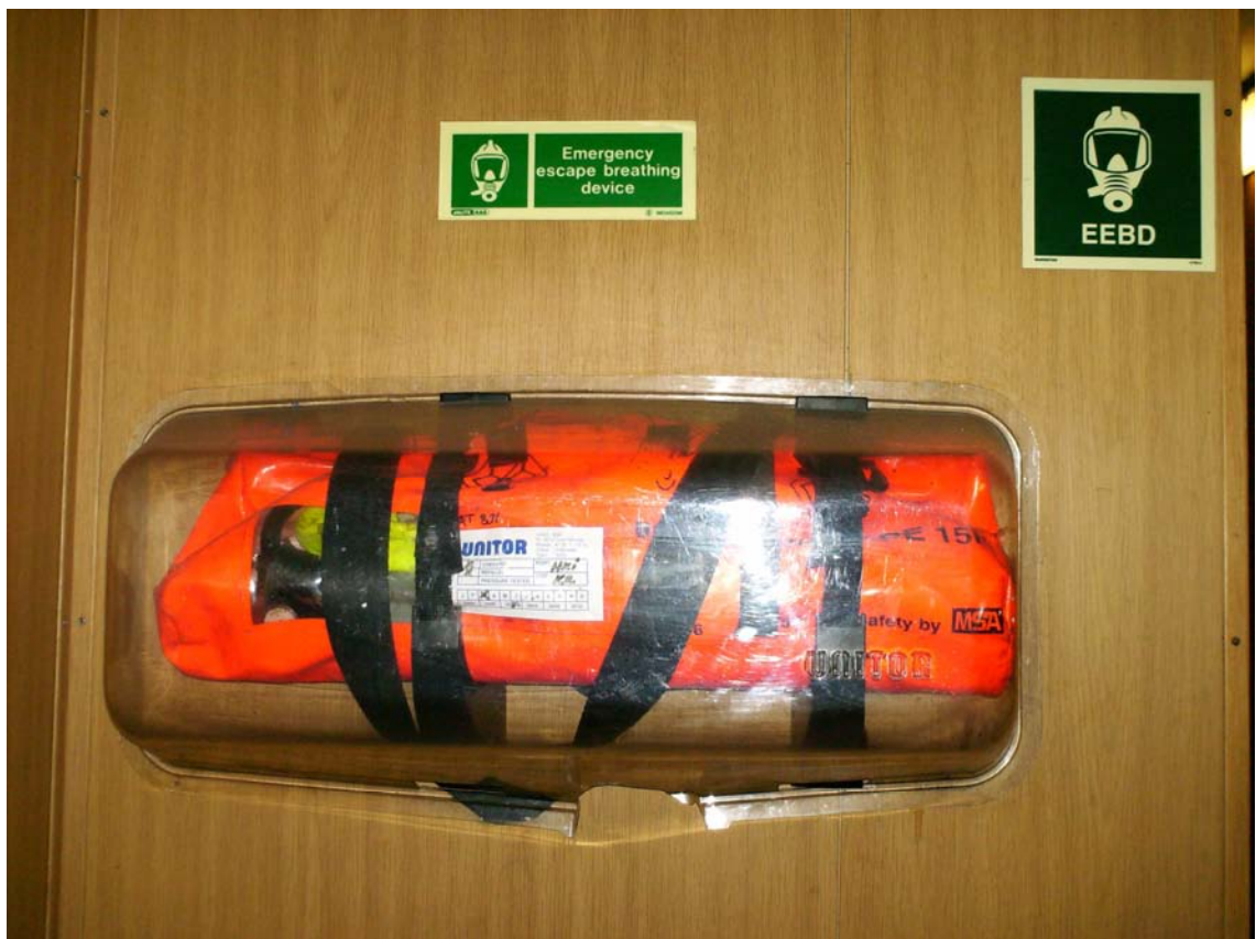
Kuva 28. EEBD-hätäpoistumislaitte ja sen symbolit.
