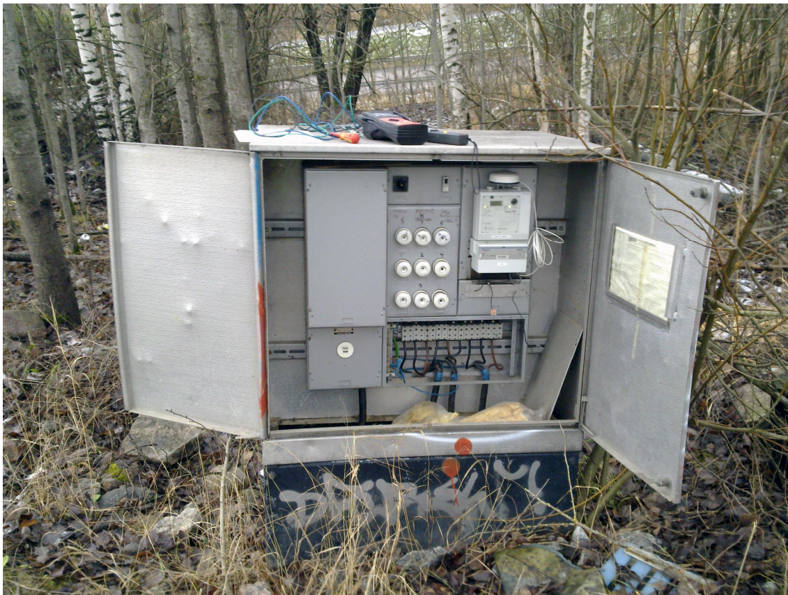
Kuva 2. TVK132 kuvattuna C2 SmartLightin kuntotutkimuksen yhteydessä vuonna 2012 (Ka-tuvalokeskusten kuntotutkimus 2012).
