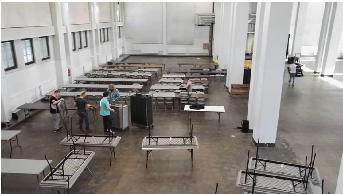
Kuva 15. PoroConin rakennusvaihe täydessä käynnissä Kattilahallissa. Eetu Perttula
