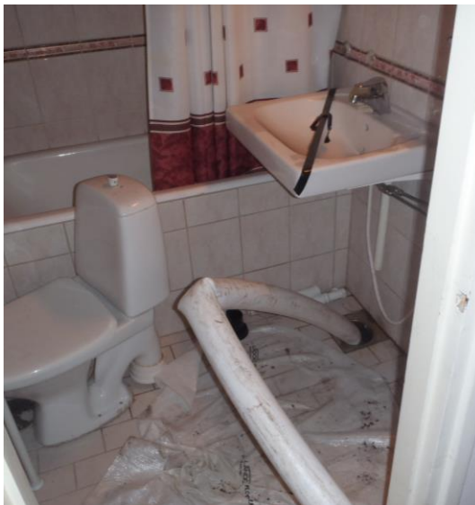
Kuva 7. Viemäriin sukitus työ käynnissä (11).
