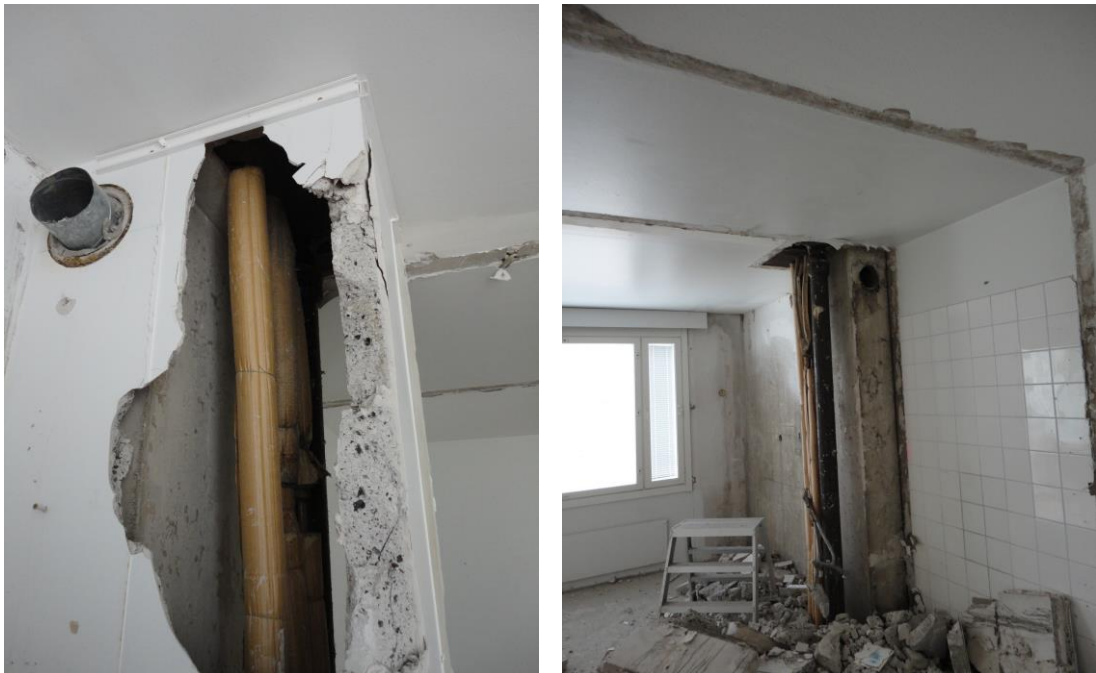
Kuvat 5 & 6. Purkutyö ”perinteisessä” putkiremontissa. Vanhat KVV-verkostot esillä. (11.)
