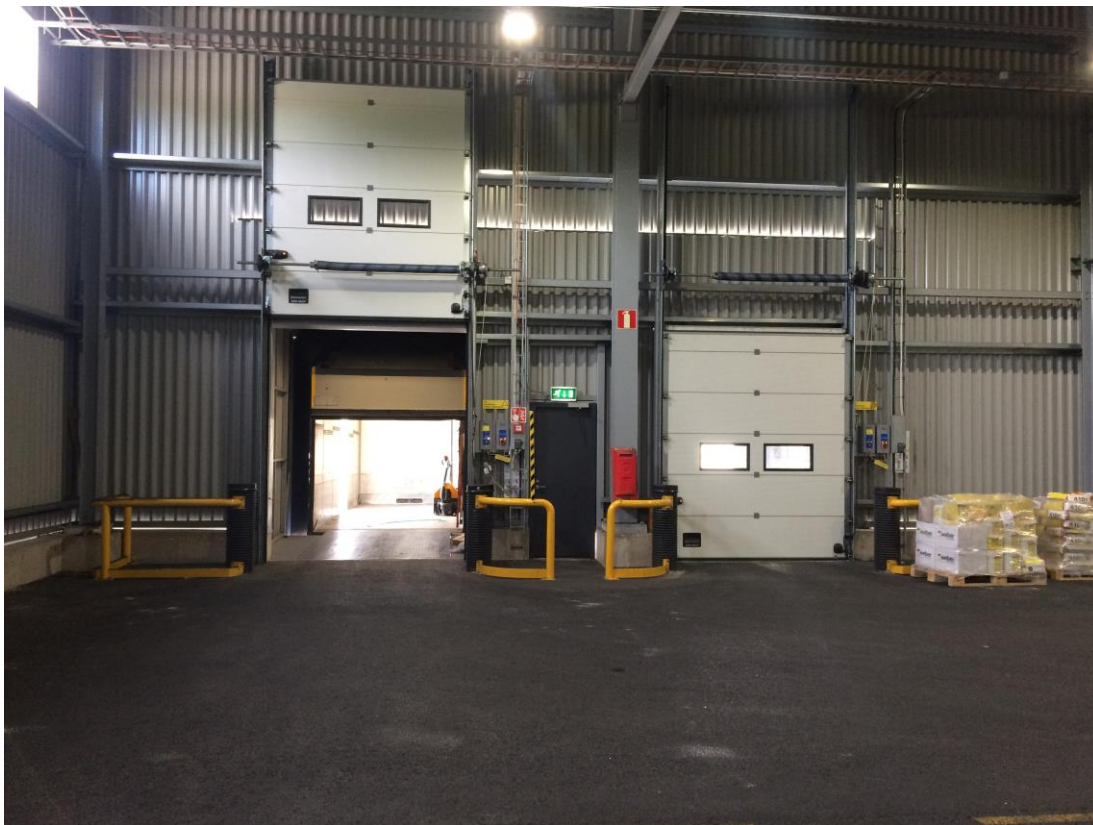
Kuva 11. Varaston päässä sijaitsevat lastauslaiturit.
