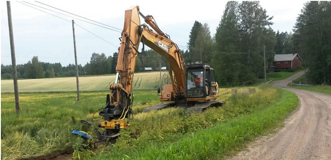
KUVA 7. Kaapelin asentaminen auraamalla (8).
