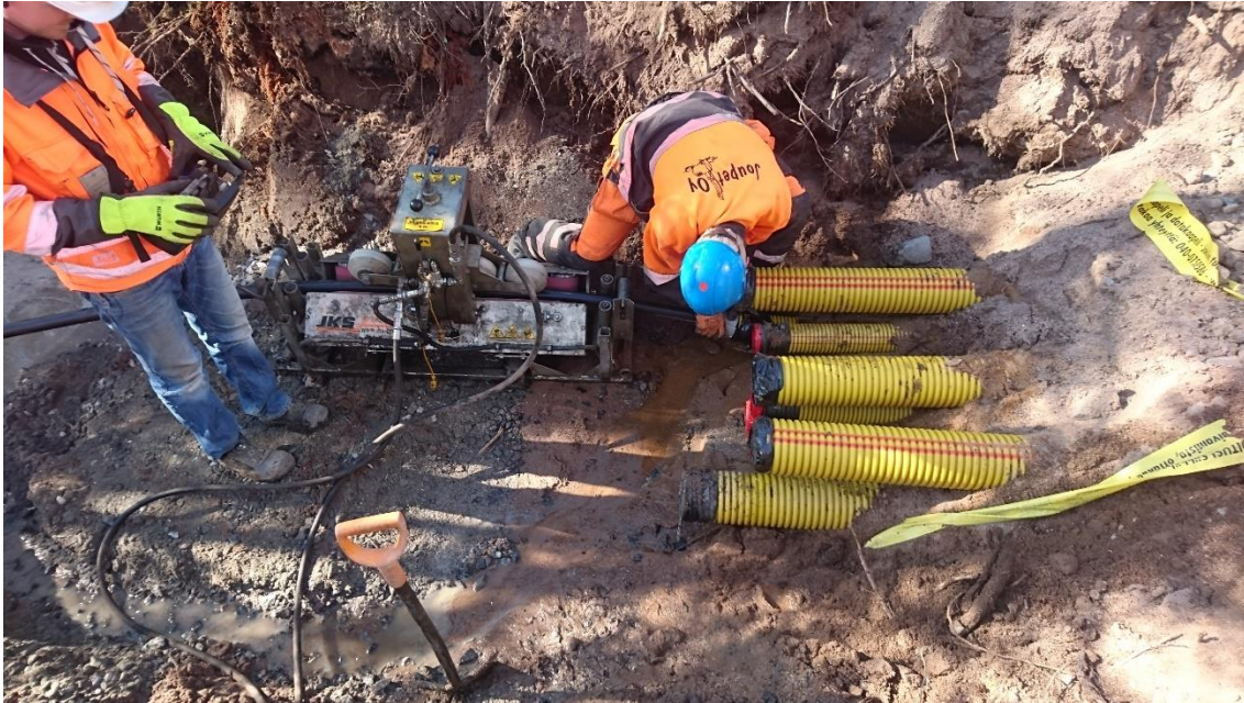
KUVA 8. Kaapelin asennus putkeen ns. kaapelikoiralla.
