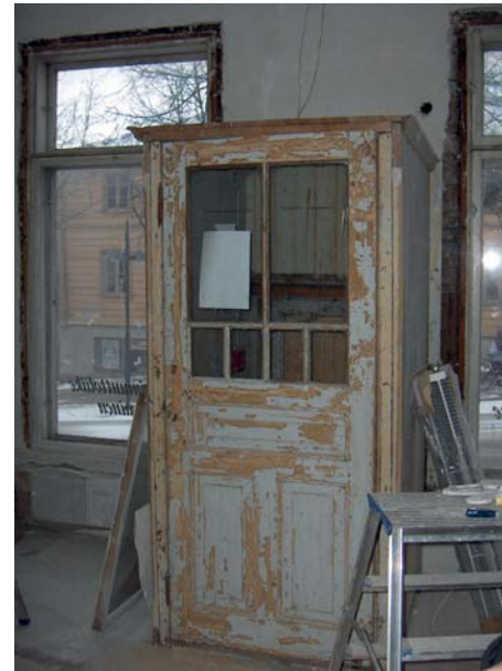
11. Ateljee-tilan tuulikaappi ennen uutta pintakäsittelyä.
