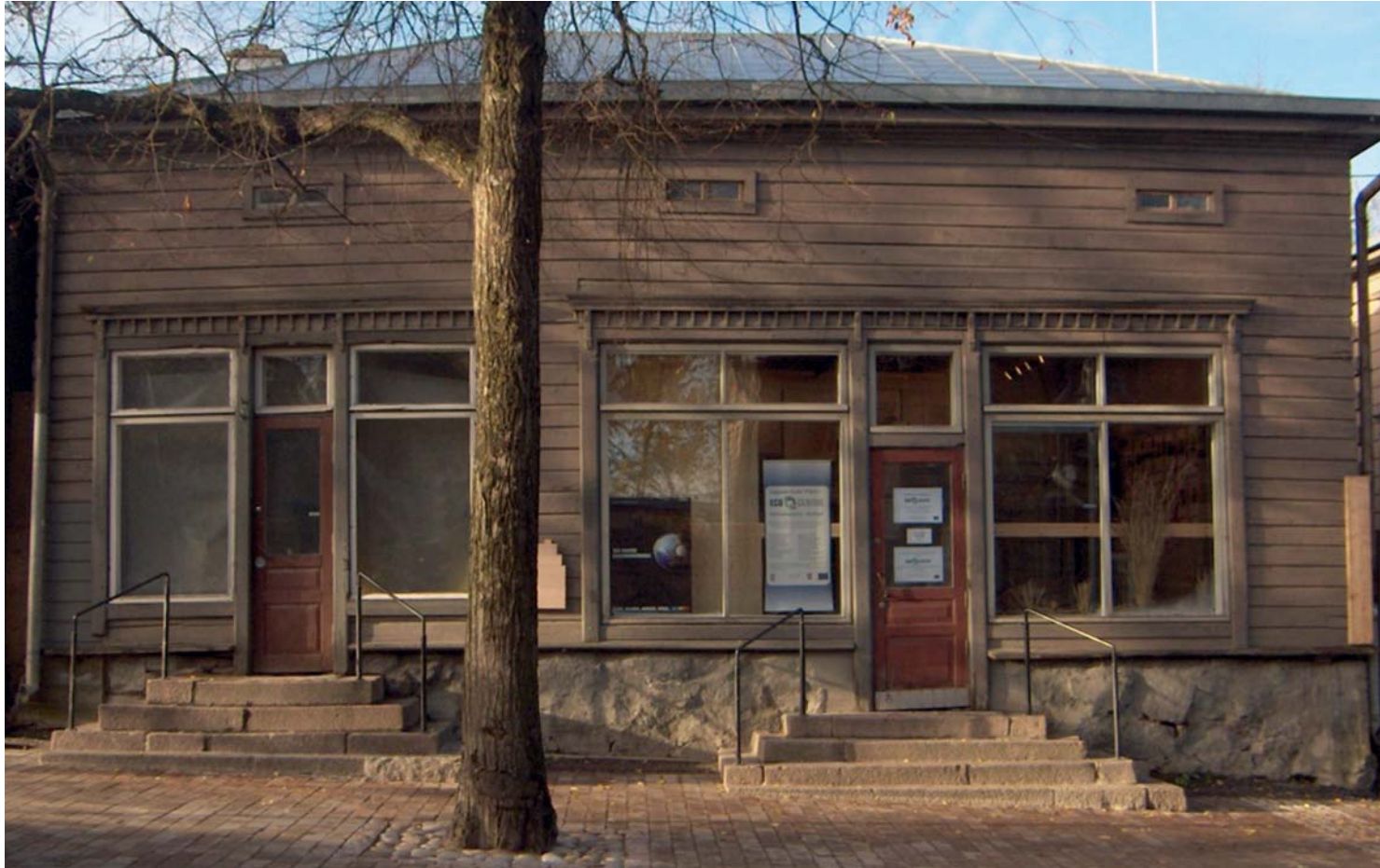
1. Tasihinin talon puotirakennus Kauppakadun puolelta. Kuva lokakuulta 2006.
