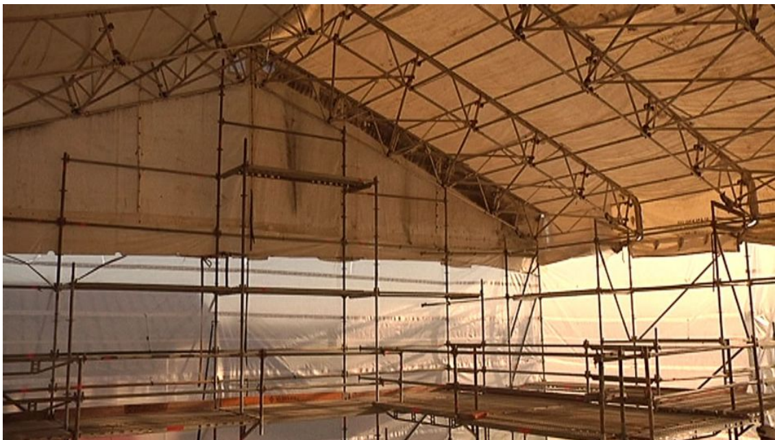
Kuva 5. Rakennustelineistä tehty kevyt sääsuoja. [15.]
