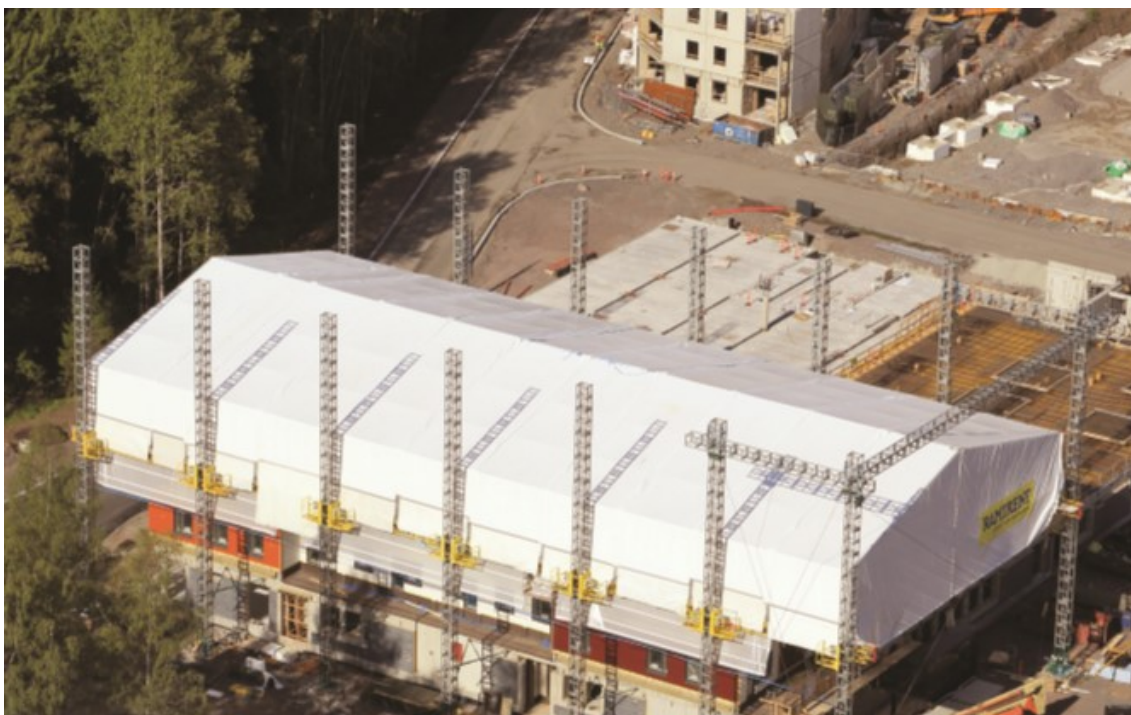
Kuva 7. Nostureilla toimiva sääsuoja. [12.]
