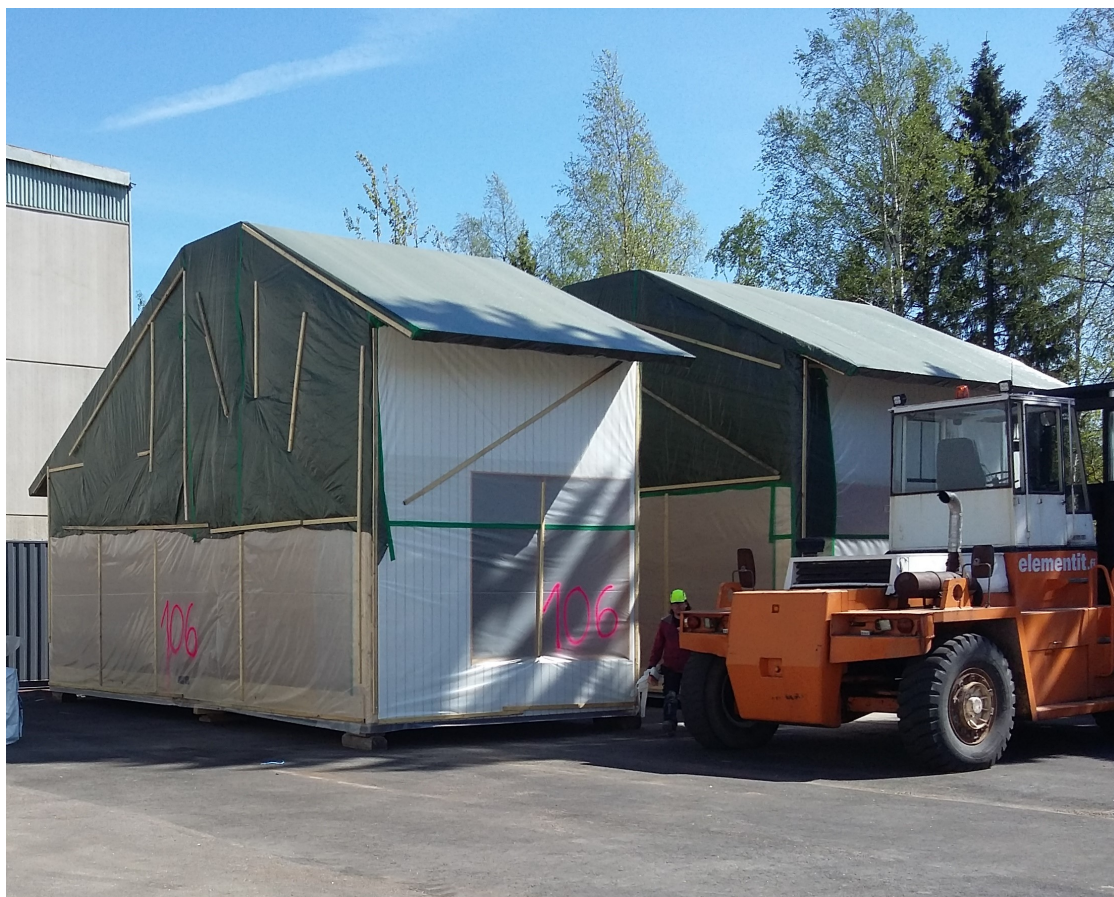
Kuva 10. Pakatut moduulielementit valmiina kuljetukseen.
