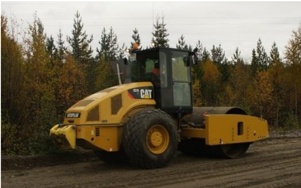
KUVA 3. Täryjä tiivistämässä tierakennetta
