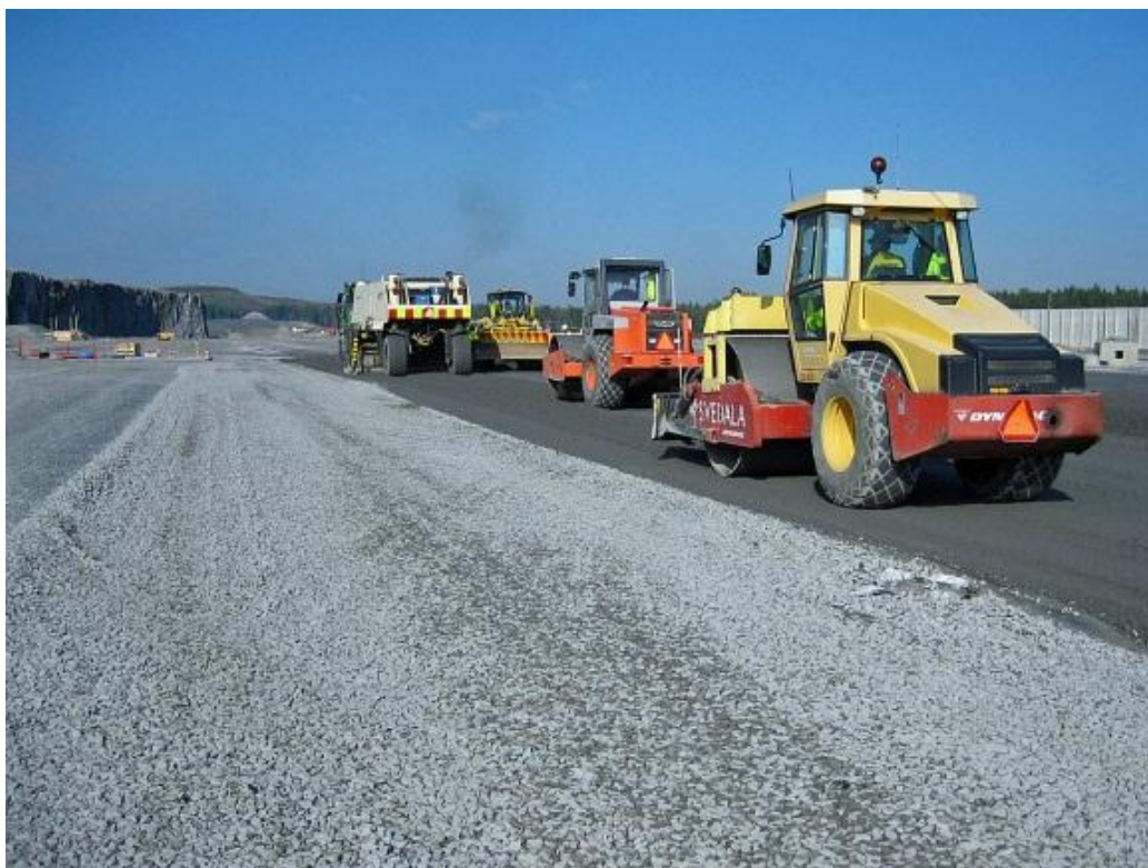
KUVA 1. Kerrostabilointityöt käynnissä Vuosaaren satamassa (3, s. 27)
