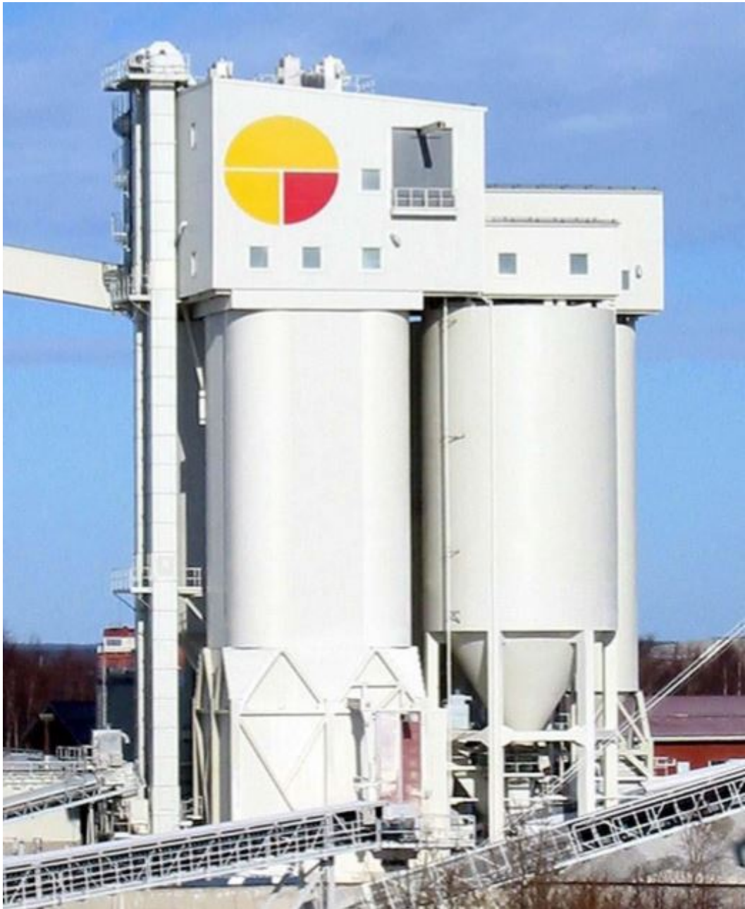
Kuva 10. Lopputuotesiilo. SMA Mineral Oy:n Tornion Röyttän kalkkitehdas.
