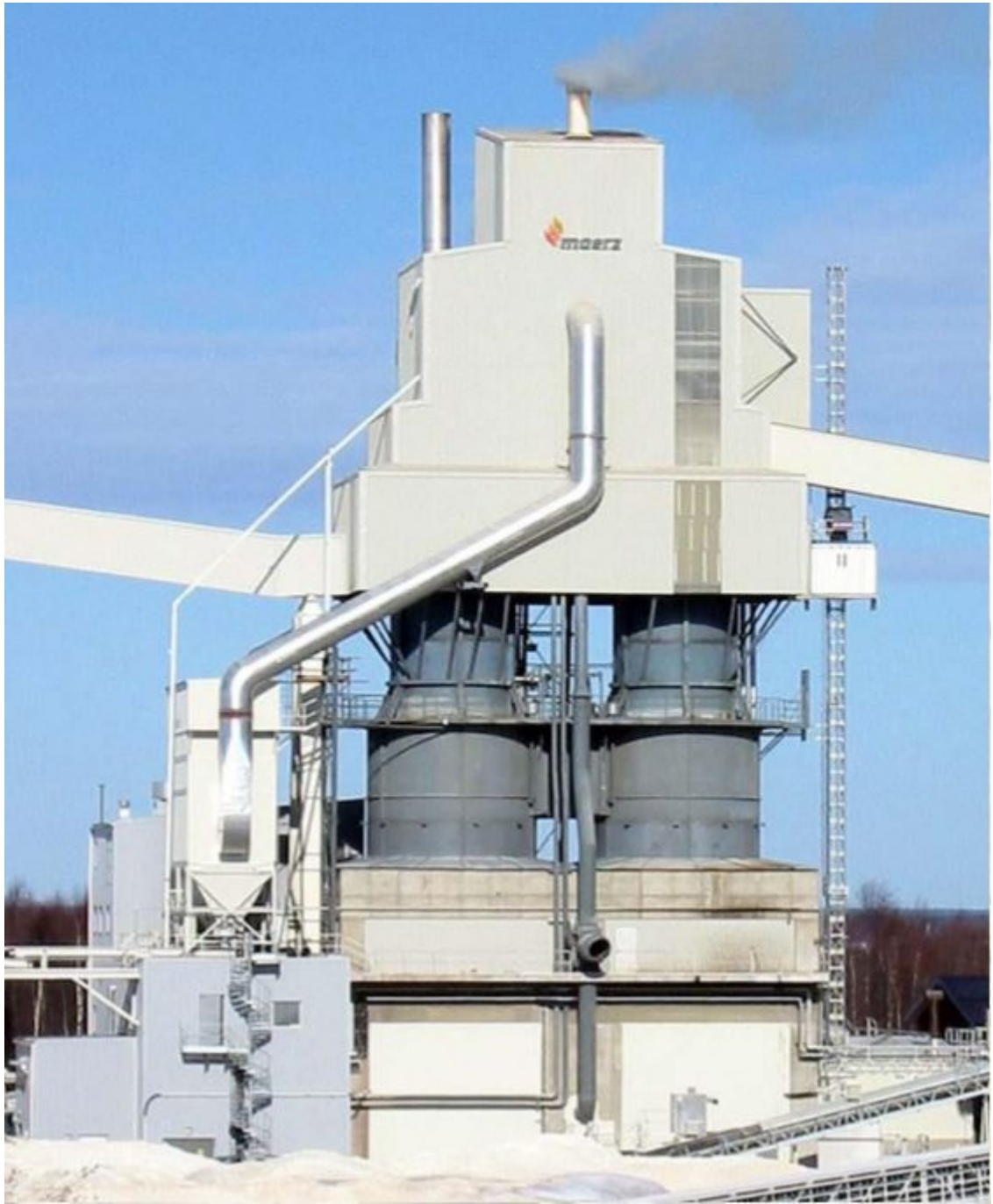
Kuva 9. Maerz kaksoikuilu-uuni. SMA Mineral Oy:n Tornion Rönttän kalkkitehdas.
