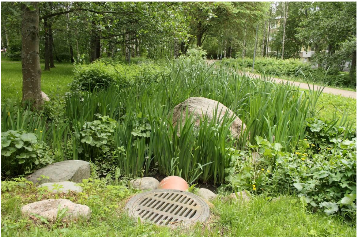
Kuva 13. Esimerkki luonnonmukaisen hulevesien hallinnan ja putkistojärjestelmän yhdistelmästä Helsingin Puotilasta.
