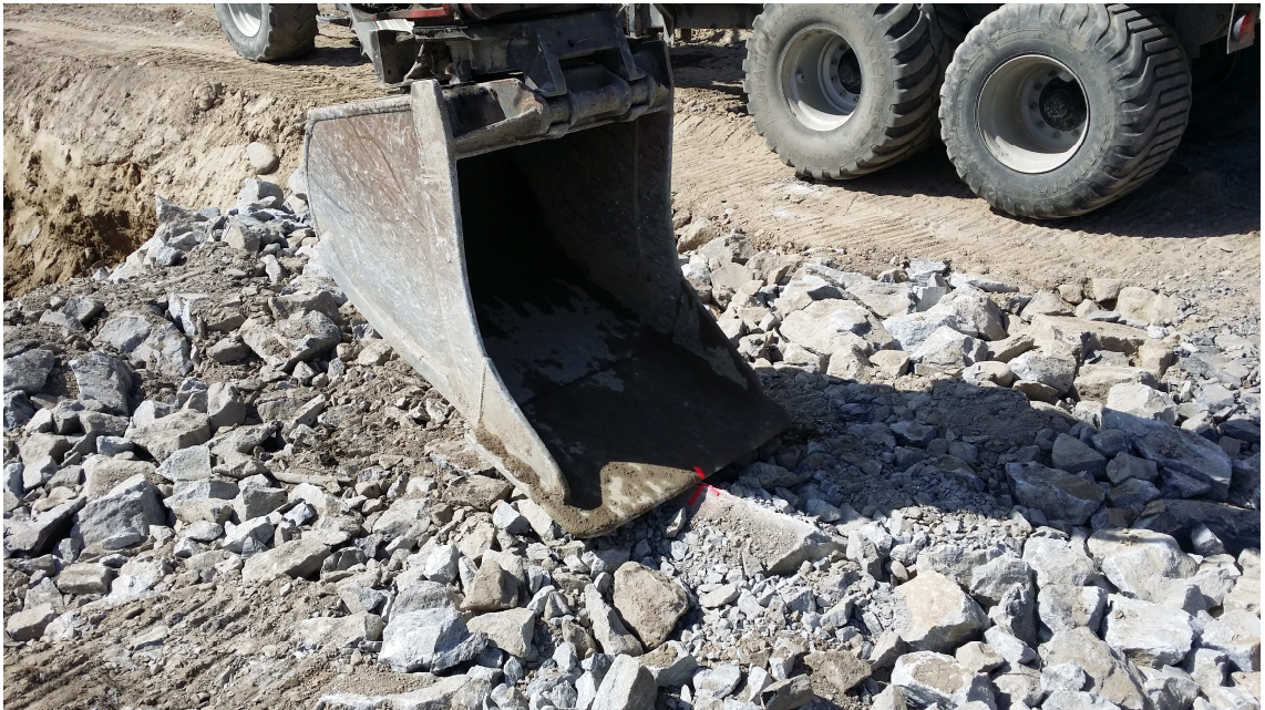
Kuva 9. Kaivinkoneen koneohjausjärjestelmän viikotarkastus. Kauhan keskipiste asetettu GNSS-mittalaitteella mitatulle pisteelle. Kuva Janne Heikkinen
