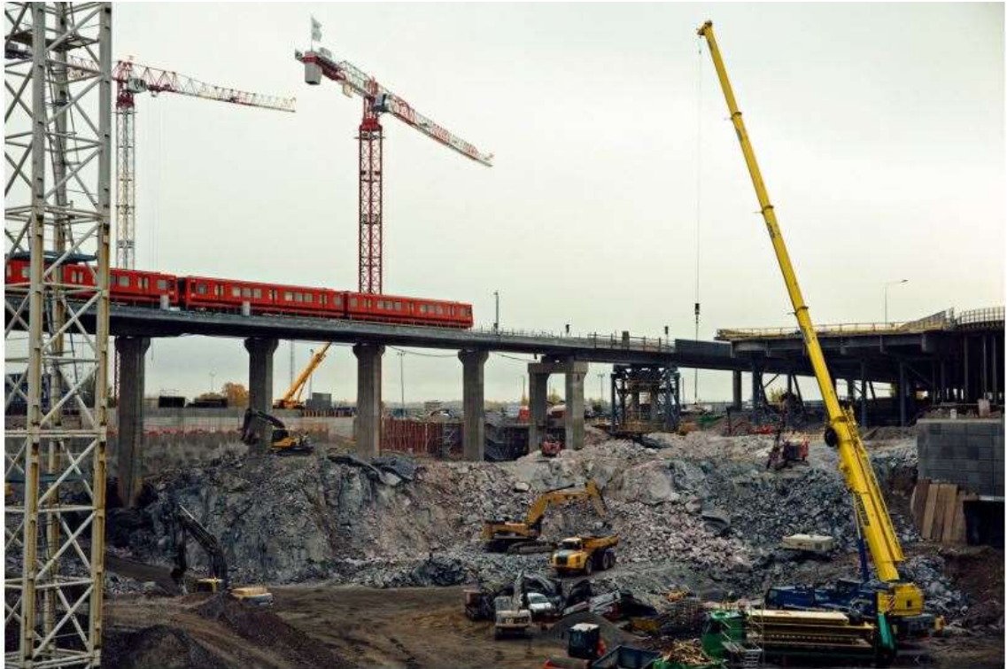
Kuva 2. REDI:n maanrakennustöitä vuodelta 2015. [5]
