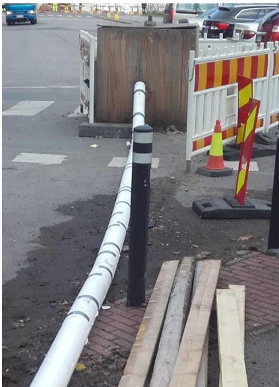
Kuva 16. Työmaan väliaikainen imeytysjärjestelmä eristettynä.
