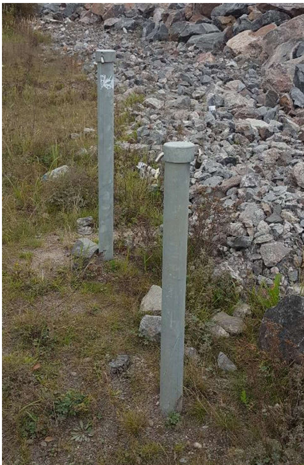
Kuva 13. REDI työmaalle asennettuja pohjaveden tarkkailu putkia.
