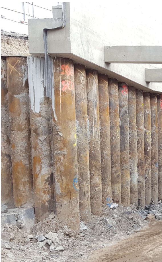
Kuva 12. Ajotunnelin avo-osuuden patoseinää.
