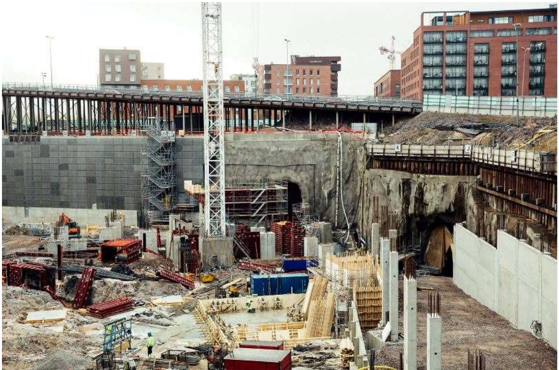
Kuva 11. Kalasatamassa sijaitsevan REDI työmaan vesitiiviitä teräsrakenteita.
