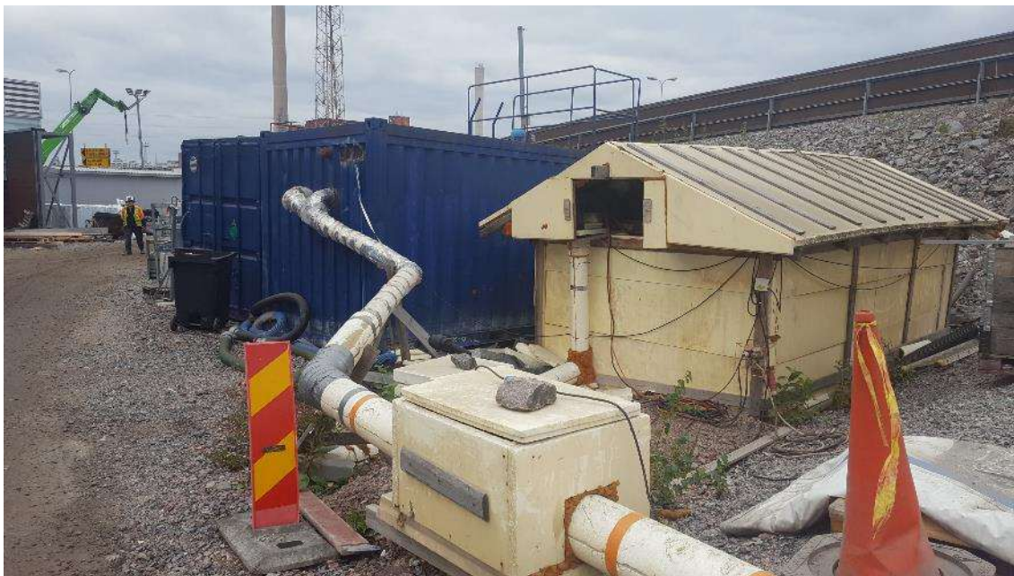
Kuva 14. Eristettyjä selkeytsaltaita, jotka selkeyttävät työmaalta pumpattavaa vettä.
