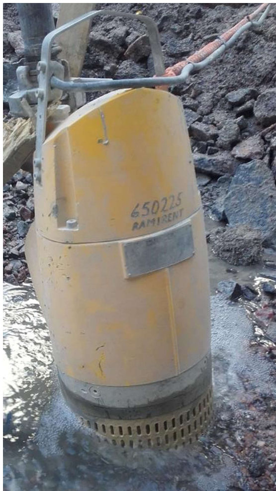
Kuva 8. Työmaalla käytössä oleva voimavirralla toimiva pumppu.
