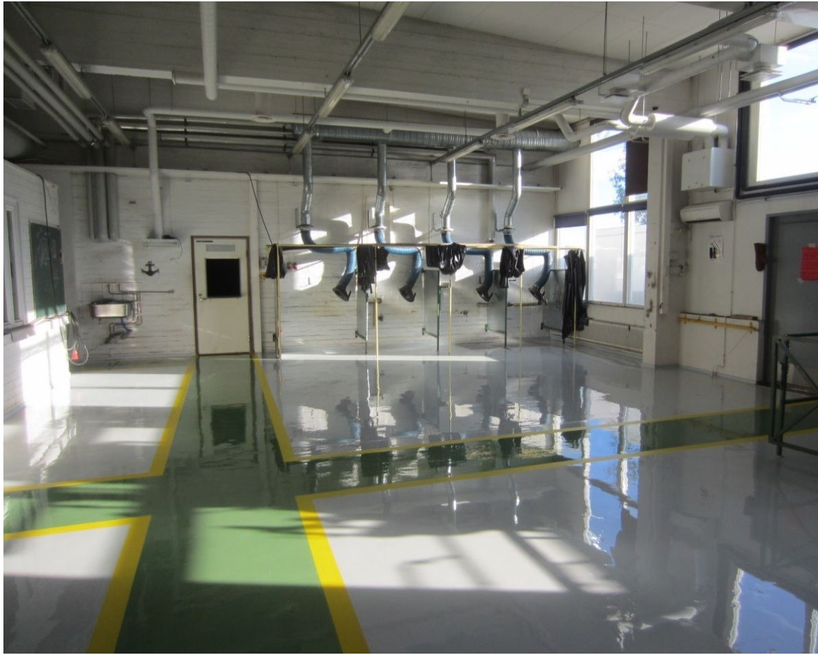
Kuva 2. Konesali lattiaremontin jälkeen.
