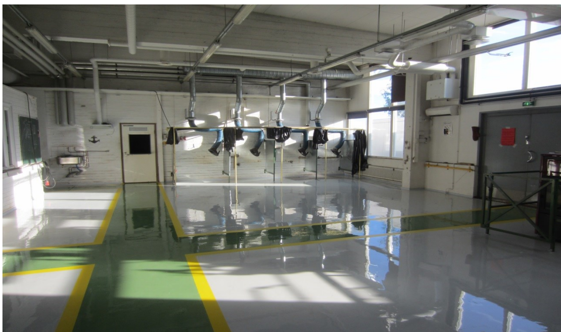
Kuva 6. Konesali ja hitsauspisteitä talotekniikan perustöille
