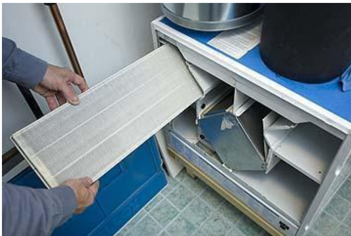
Kuva 5. Ilmansuodattimen vaihto ja puhdistus (10).
