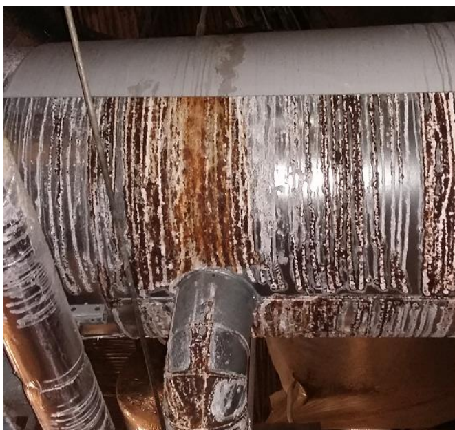
Kuva 6. Kaukolämpöputken pellitystä on suojattu U-profiili-suojalla
