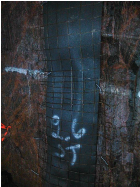
Kuva 1. Salaojitus kaukolämpötunnelin seinämässä odottamassa betonointia
