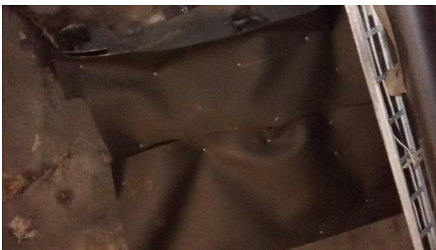
Kuva 8. Tunnelimatolla pyritään hallitsemaan suurempia vuotovesiä
