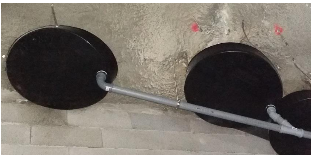
Kuva 7. Kattolautasilla pyritään hallitsemaan pistemäisiä valumavesivuotoja
